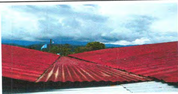
Foto 5: SUSTITUCIÓN DE LÁMINA
