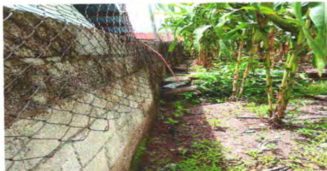
FOTO 7: SUSTITUCION DE MURO PERIMETRAL
