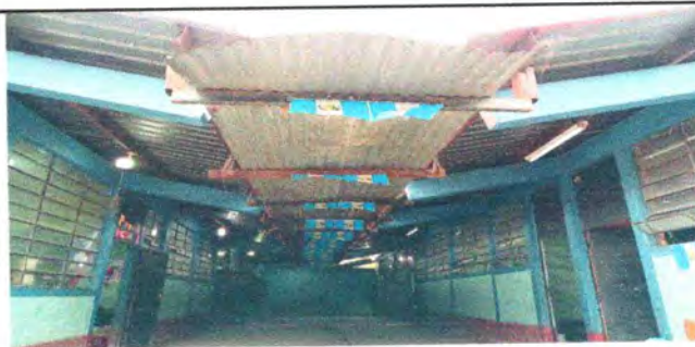
Foto 6: SUSTITUCION DE LAMINA DE CORREDOR
