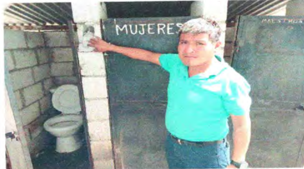
Foto 2: SUSTITUCION DE PUERTAS DE SANITARIOS Y COLOCACION DE PISO ANTIDESLIZANTE
