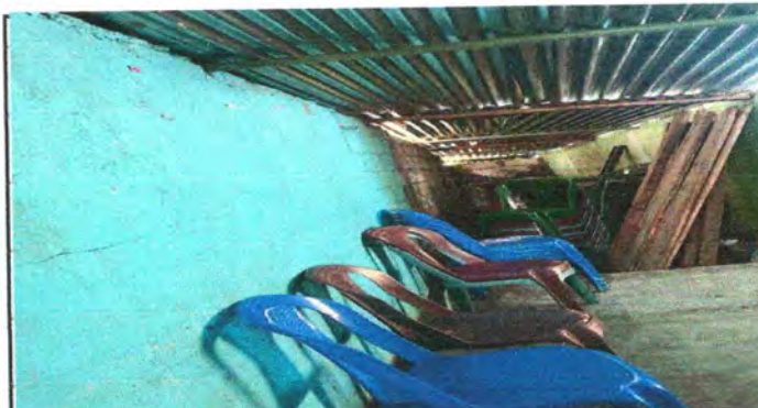
Foto 4: SUSTITUCION ESTRUCTURA LAMINA PASILLO
