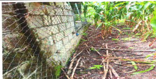
Foto 8: SUSTITUCION DE MURO PERIMETRAL
