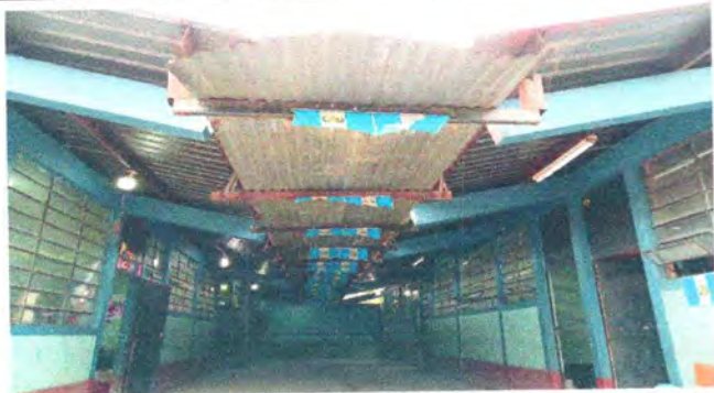
Foto 1: SUSTITUCION DE LAMINA Y ESTRUCTURA DE CORREDOR Y COLOCACION DE CANAL PVC
