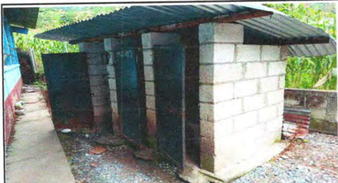
Foto 3: SUSTITUCIÓN DE LAMINA Y ESTRUCTURA DE SANITARIOS
