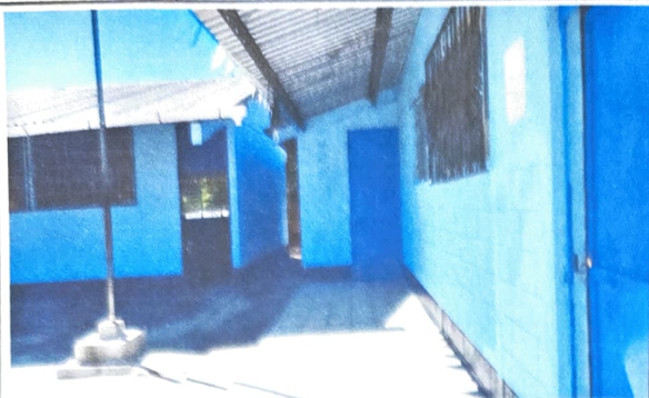
FOTO 1: MANTENIMIENTO A ESTRUCTURAS
