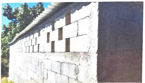
FOTO 5: LEVANTADO DE MUROS PARA LAVAMANOS
