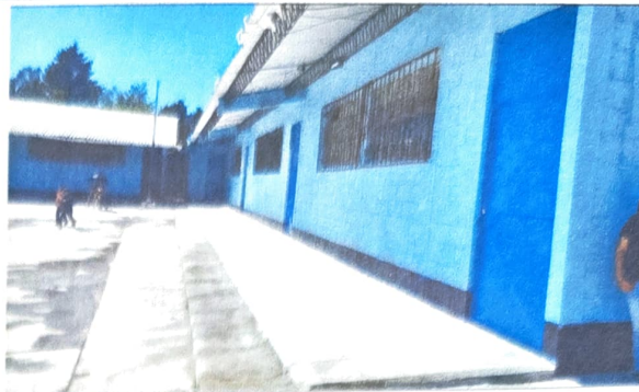
FOTO 2: SUSTITUCIÓN DE CHAPA
