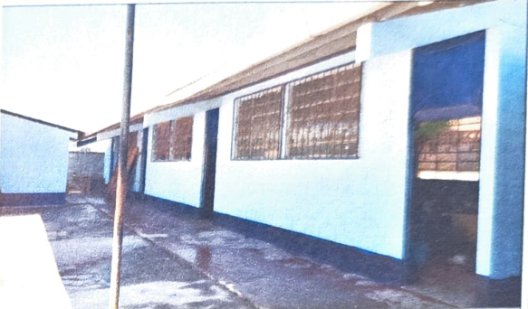
FOTO 4: SUSTITUCIÓN DE CANALES DE PVC
