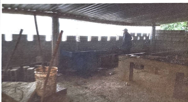
FOTO 5: LEVANTADO DE MUROS PARA LAVAMANOS
