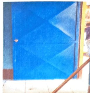
FOTO 2: SUSTITUCIÓN DE CHAPA
