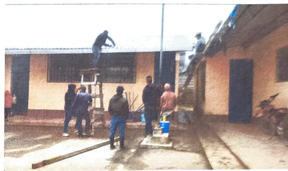
FOTO 4: SUSTITUCIÓN DE CANALES DE PVC
