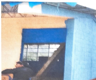
FOTO 1: MANTENIMIENTO A ESTRUCTURAS
