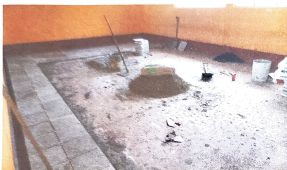
FOTO 3: SUSTITUCIÓN DE PISO DE TORTA A GRANITO
