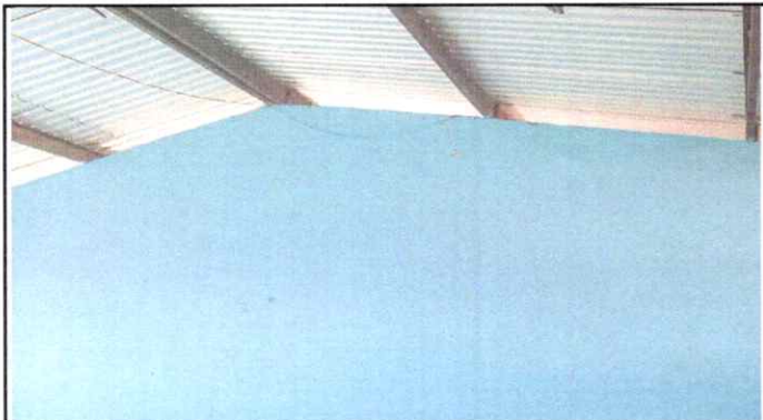
Foto 2: Paredes dentro de aulas
