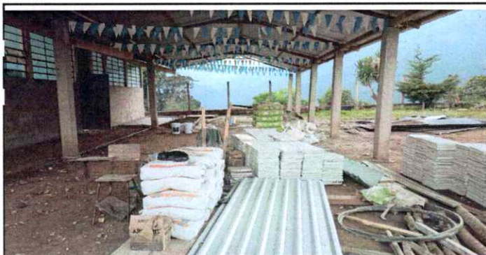
Foto 7: Materiales a utilizar en remozamiento
