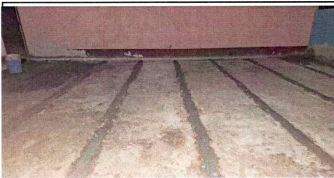
Foto 10: Preparación de suelo para colocación de pisos
