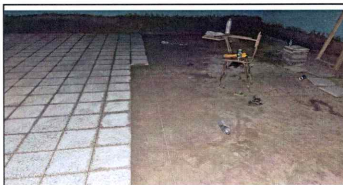
Foto 12: Colocación de pisos de granito segundo salón
