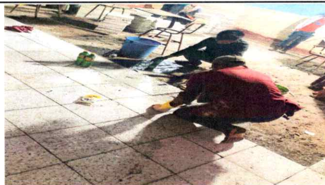
Foto 4: Colocacion de piso de Granito
