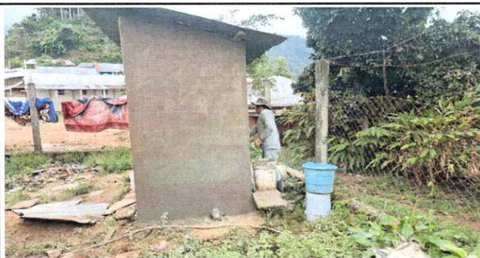
Foto 3: Trabajando repello de sanitarios
