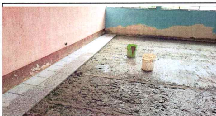
Foto 11: Inicio en colocación de pisos
