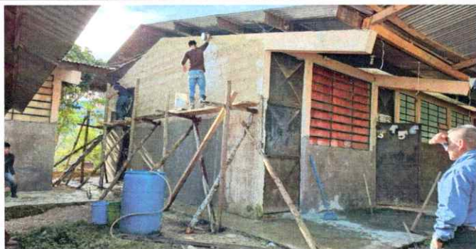
Foto 1: Trabajando Repello en paredes
