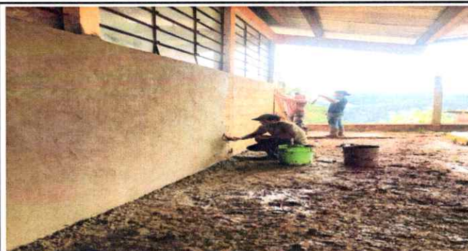
Foto 2: Trabajando Repello en paredes
