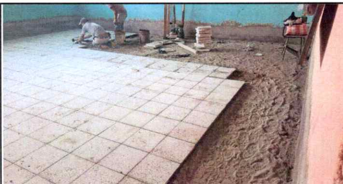
Foto 6: Colocación de pisos de granito primer salón
