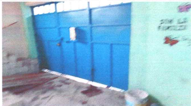
Foto 1: Instalación completada de portón desde otro ángulo
