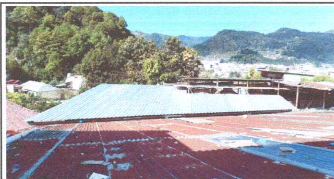
Foto 5: Intalación de techo completado desde otro angulo
