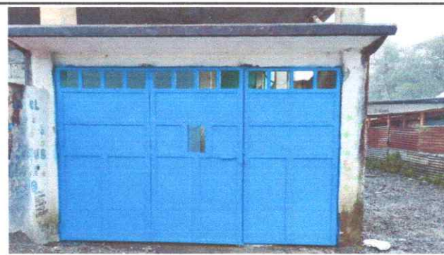
Foto 6: Instalación completada de portón
