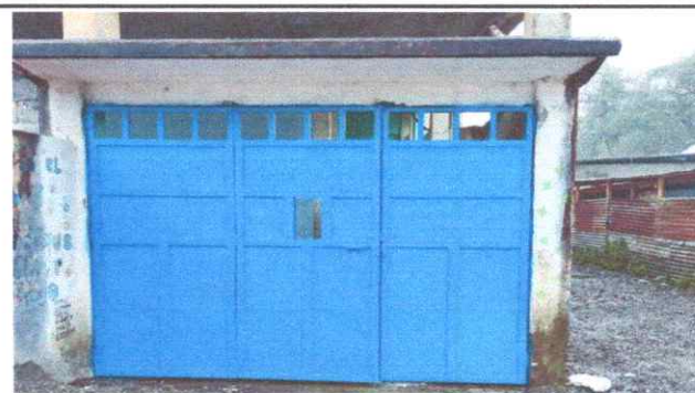
Foto 6: Instalación completada de portón
