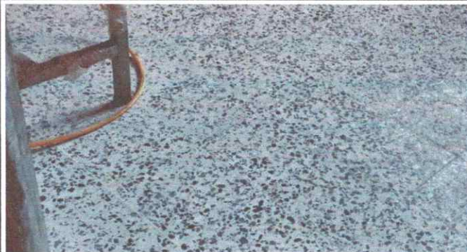
Foto 2: Proceso Instalación de piso completado
