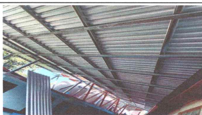
Foto 4: Intalación completada de laminas
