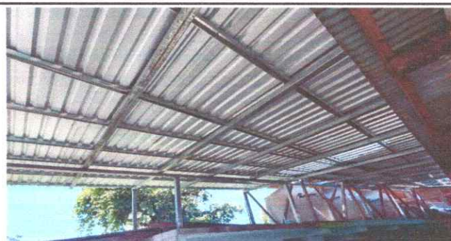
Foto 2: Intalación completada de techo
