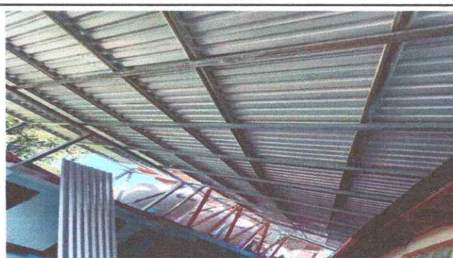
Foto 4: Intalación completada de laminas
