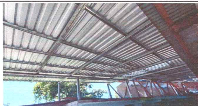
Foto 2: Intalación completada de techo
