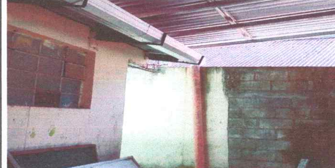
Foto 6: Finalización de Instalación de aguas fluviales
