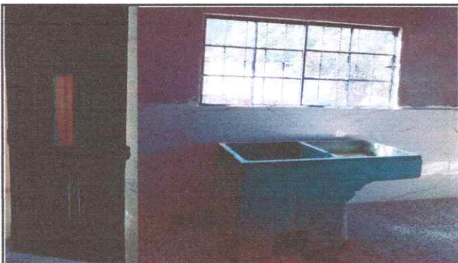
Foto 3: Instalacion de pared, puertas y ventanas completadas
