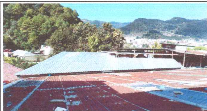
Foto 5: Intalación de techo completado desde otro angulo
