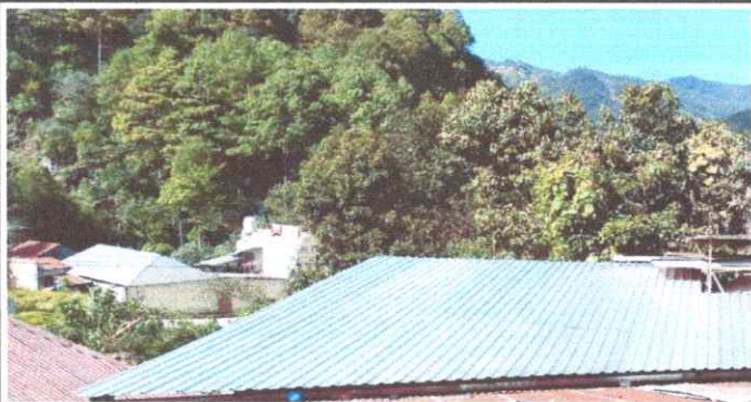
Foto 3: Proceso de cambio de techo
