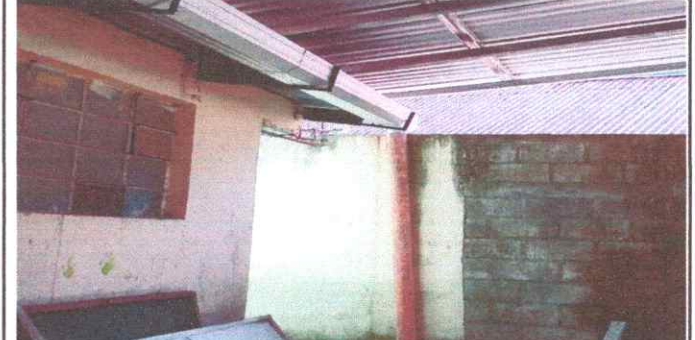
Foto 6: Finalización de Instalación de aguas fluviales
