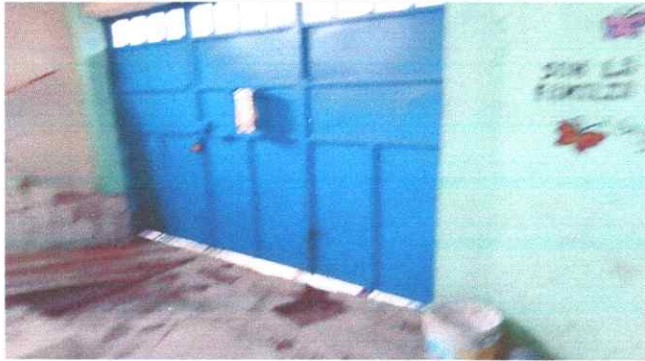
Foto 1: Instalación completada de portón desde otro ángulo
