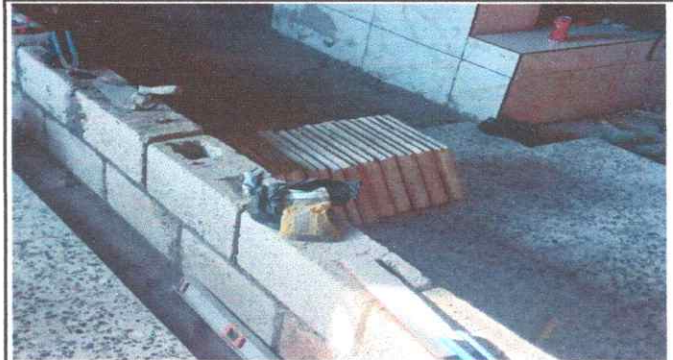
Foto 2: Proceso de sustitución de piso
