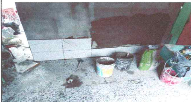
Foto 3: Proceso de colacion de la pared y ventanas
