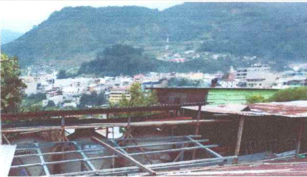
Foto 3: Proceso de cambio de techo
