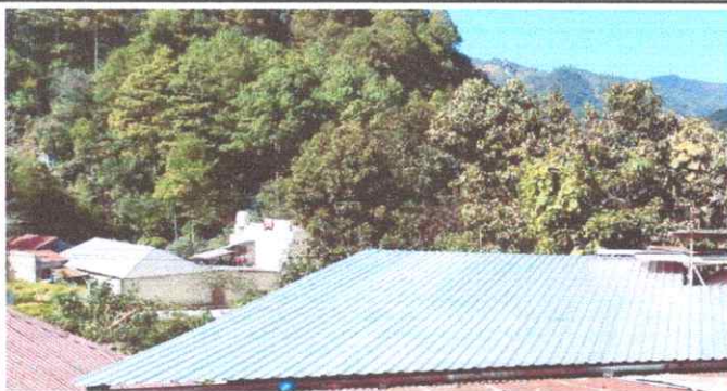
Foto 3: Proceso de cambio de techo
