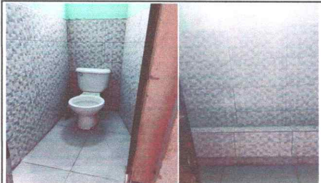
Foto 4: Proceso de mantenimiento de sanitario con instalación de azulejo
