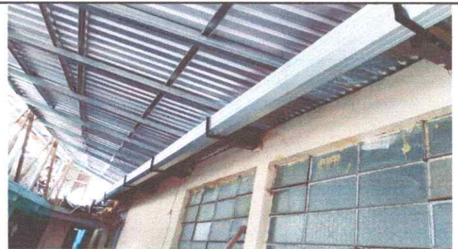
Foto 6: proceso de mejoramiento de salida de aguas fluviales
