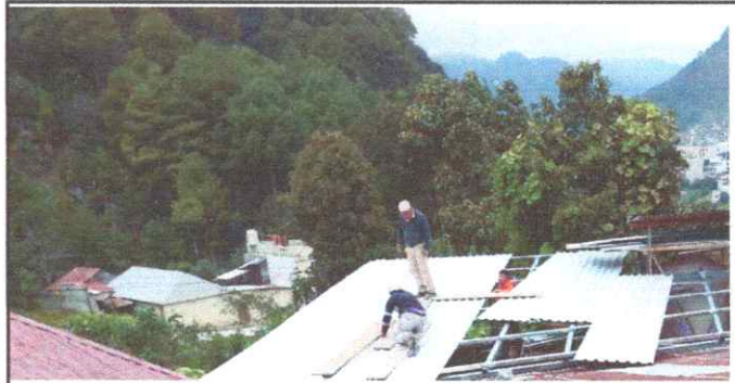
Foto 4: Proceso de instalación de laminas
