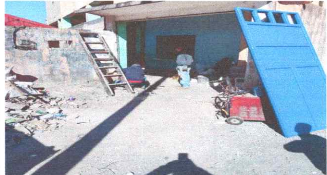
Foto 6: Proceso de instalación de portón
