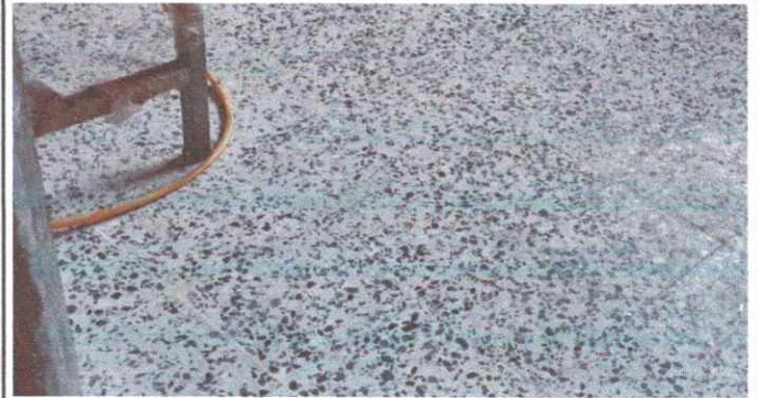
Foto 2: Proceso Instalación de piso completado
