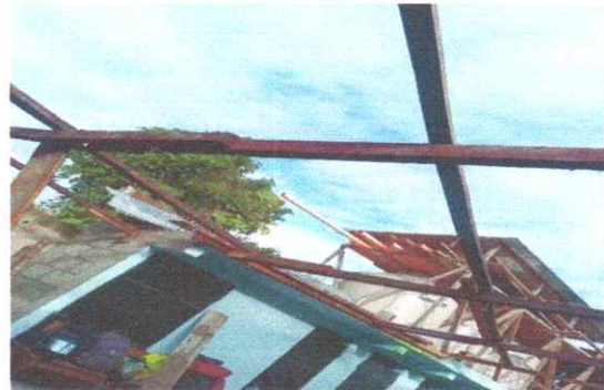
Foto 2: Proceso de desinstalacion de techo en mal estado
