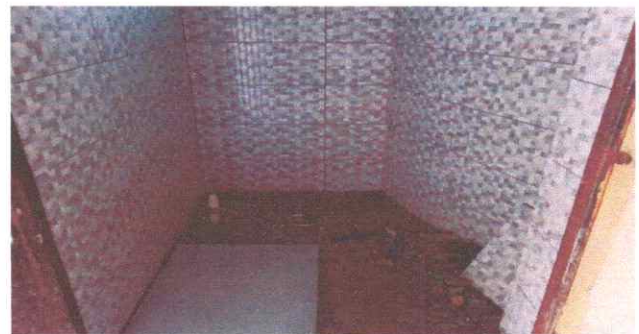
Foto 4: Proceso de mantenimiento de sanitario con instalación de azulejo
