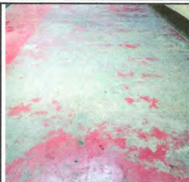
Foto 2: Sustitución de piso en la cocina
