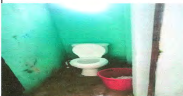
Foto 4: Mejoramiento de sanitarios con azulejo
