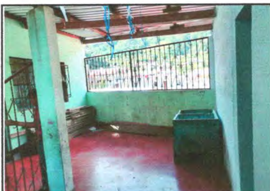
Foto 3: Colocación de la pared y ventana
