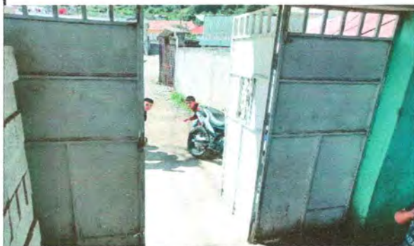
Foto1: Cambio de portón por deterioro
