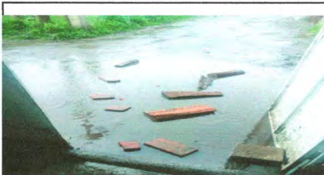
Foto 6: Salida de las aguas fluviales
