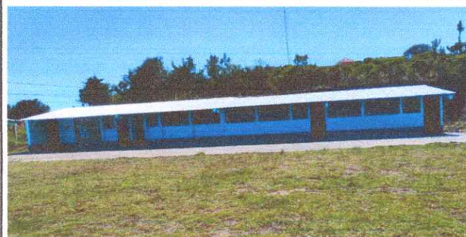
Foto 1: Finalización de techos
