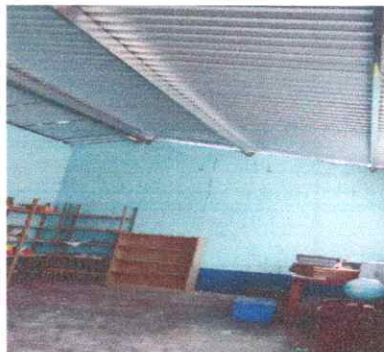
Foto 2: Terminación de costaneras
