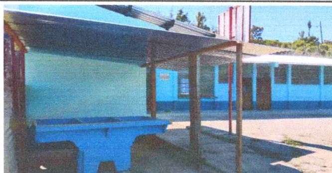
Foto 6: Pila de cemento instalada
