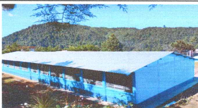
Foto 4: Finalización de pintura
