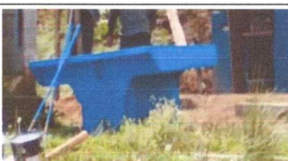
Foto 6: pila de dos lavadero nuevo
