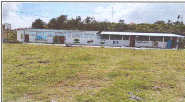
Foto 1: Colocación de techos
