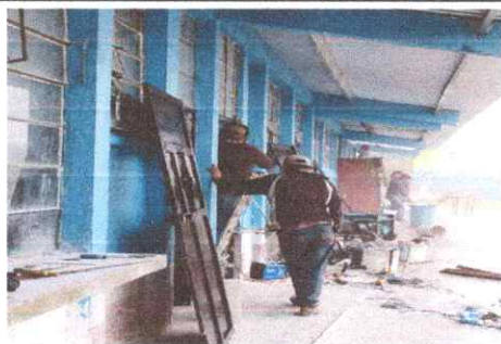
Foto 3: Colocación de puertas
