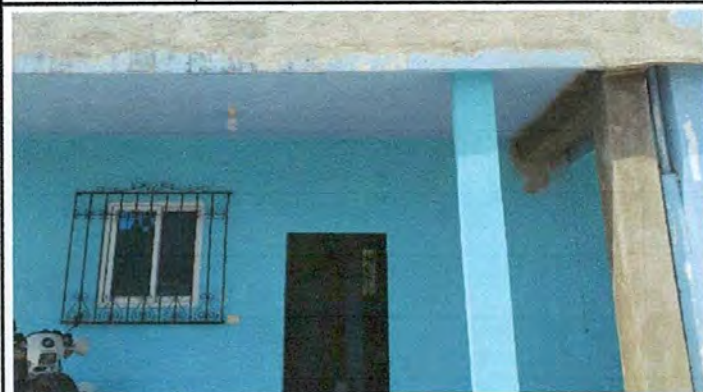
Foto1: Sustrucción estructura de techo
