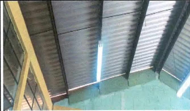
Foto7: Sustrución de focos
