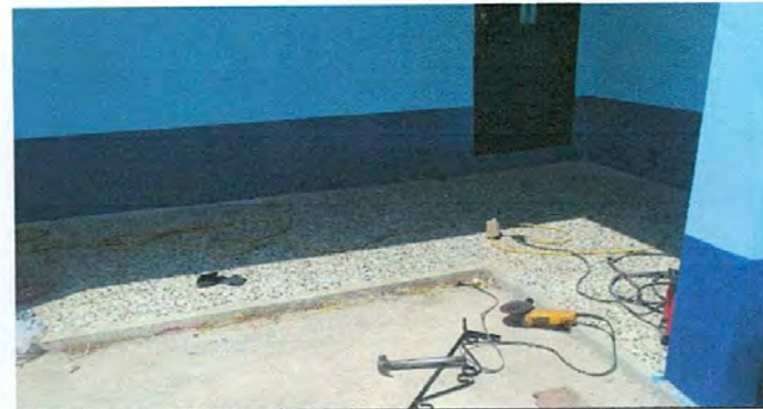
Foto 6: Sustrucción de pintura para aulas.
