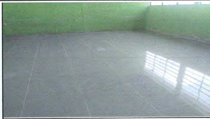
Foto 2: Sustrucción de piso por cerámica
