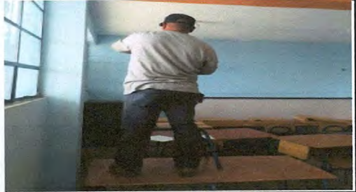
Foto 8: Sustitución de plafoneras
