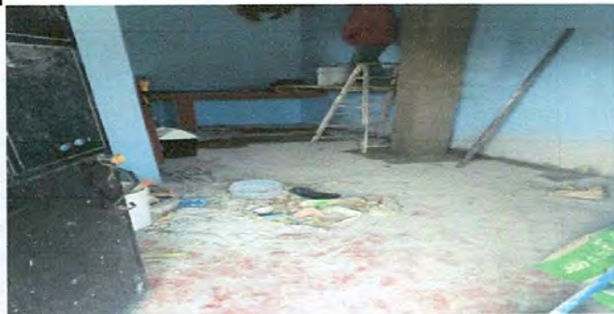
Foto 1: Sustitución estructura de techo
