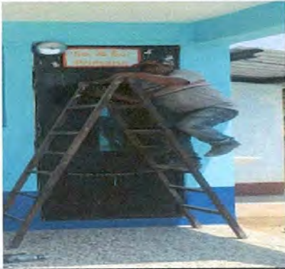
Foto7: Sustitución de focos
