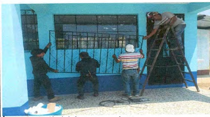
Foto 5: Sustitución de balcones para ventanas
