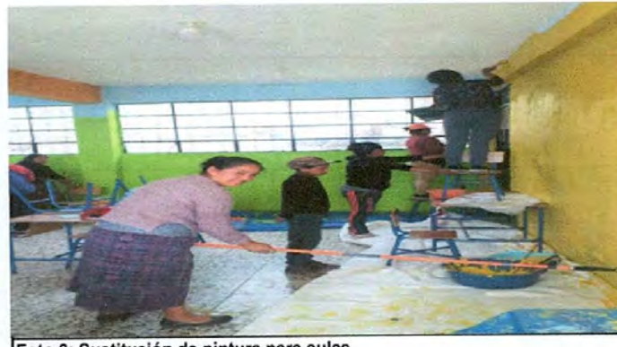
Foto 6: Sustitución de pintura para aulas.
