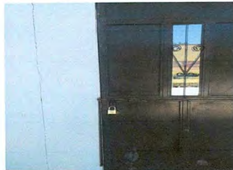
Foto 4: Sustitución de candados por chapas.
