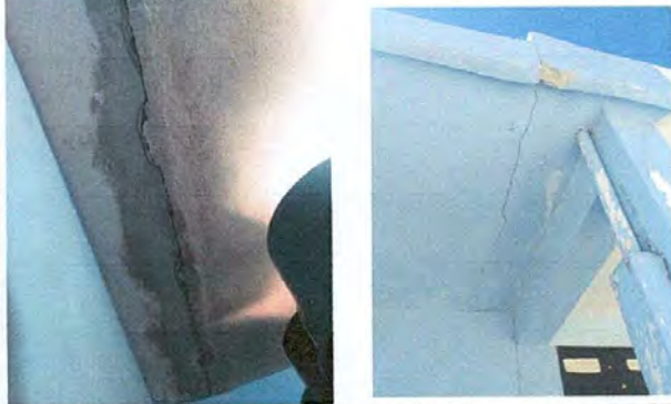
Foto 1: El techo no es seguro, se puede caer en cualquier momento, es necesario repararlo.
