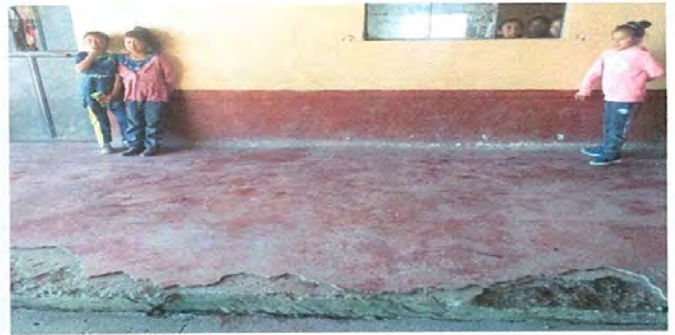
Foto 2: Sustitución de piso por cerámica de porcelanato
