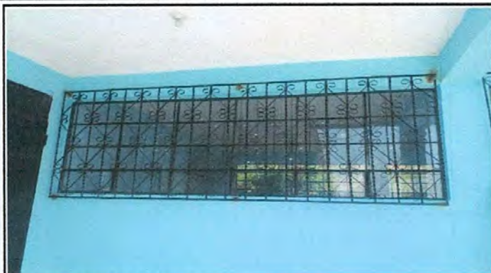
Foto 7: Sustrucción de focos
