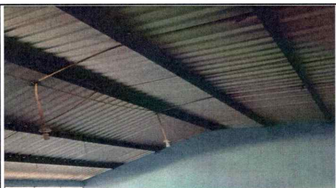
Foto 3: Cambio de lamina de aulas
