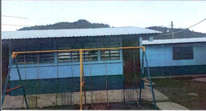
Foto7: Cambio de lamina y pintado de costanera
