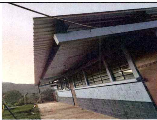
Foto 4: Cambio de lamina
