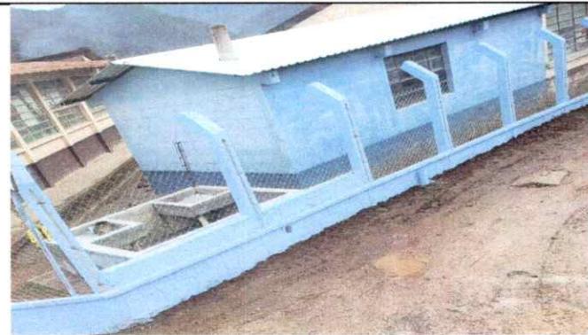
Foto 2: Cambio de lamina y pintado de costanera
