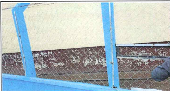
Foto1: Cambio de maya de toda la escuela
