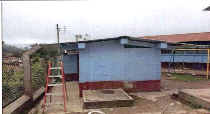
Foto 2: Cambio de lamina de baños
