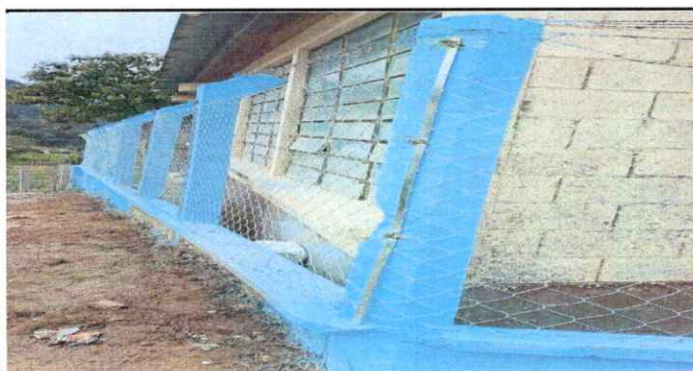
Foto 5: Pintado de muros
