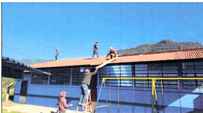
Foto 4: Cambio de lamina
