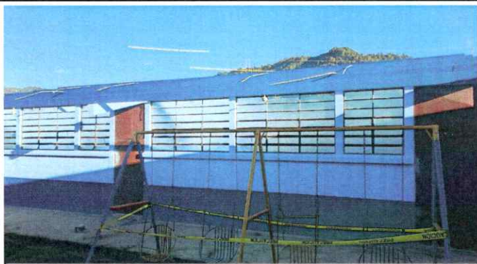
Foto 7: Cambio de lamina y pintado de costanera
