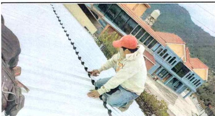
Foto 3: Cambio de lamina de cocina y costaneras
