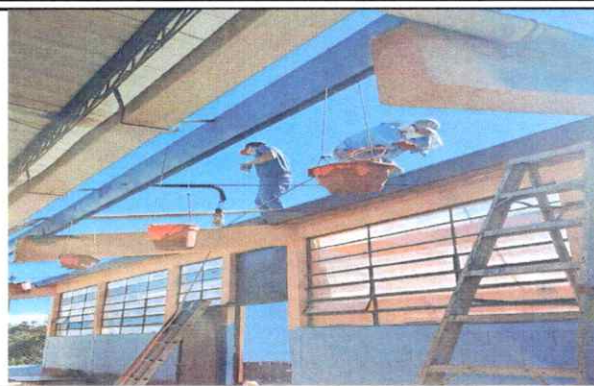
Foto 8: Cambio de lamina y pintado de costanera
