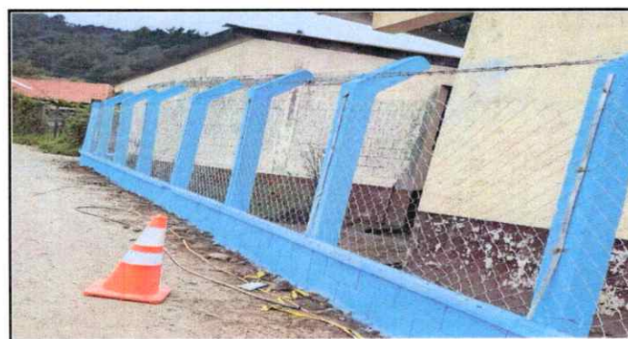
Foto 6: Pintado de muros
