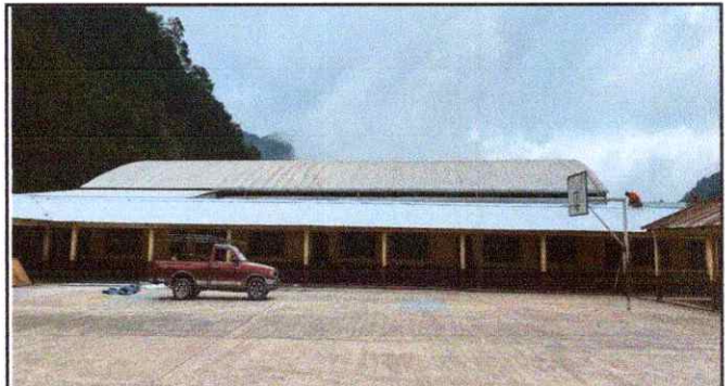
Foto 4: Imagen del area frontal donde se trabajo el remozamiento
