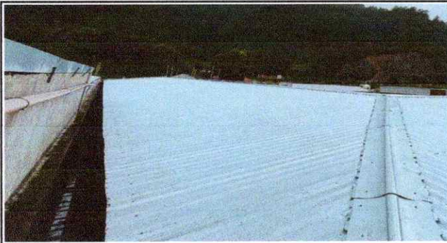
Foto1: Imagen de la nueva cubierta de lamina aluzinc
