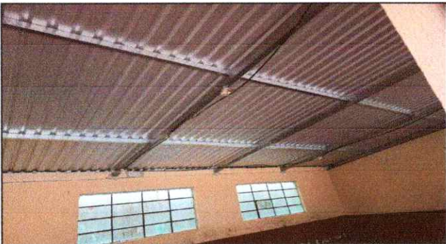
Foto 3: Imagen del aula con su nueva cubierta
