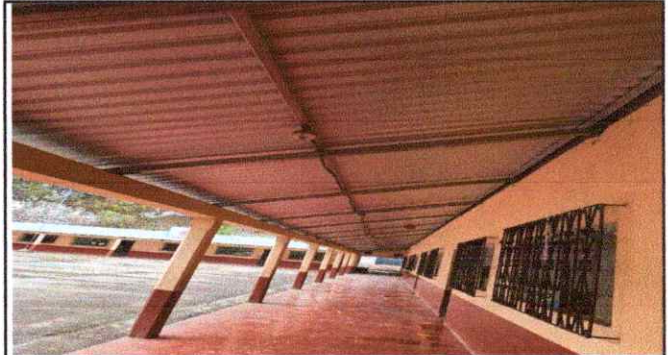
Foto 2: Imagen del corredor donde se sustituyo el entechado
