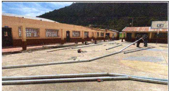
Foto 4: Preparan las costaneras nuevas tomando las medidas para el corte necesario y la unión de las mismas
