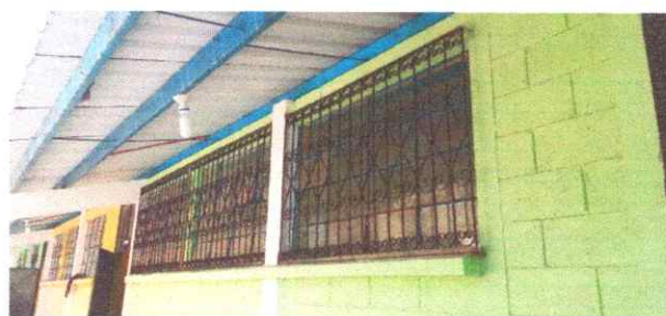
Foto 4: Mejoramiento balcones en laboratorio de computación
