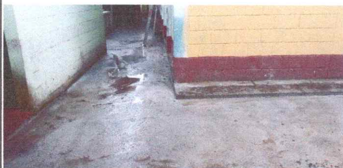
Foto 5: Reparación piso patio
