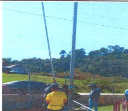
Foto 2: Sustitución de ducto electros y accesorios
