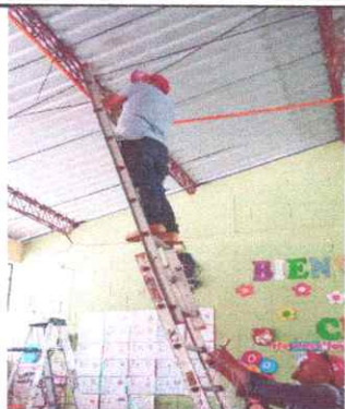
Foto1: Reparación Sistema electrico
