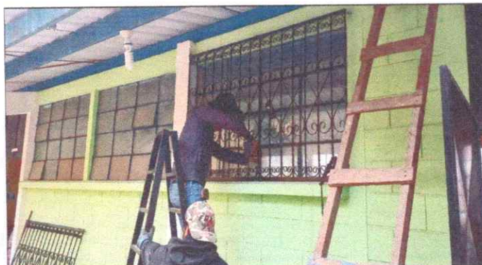
Foto 4: Mejoramiento balcones en laboratorio de computación
