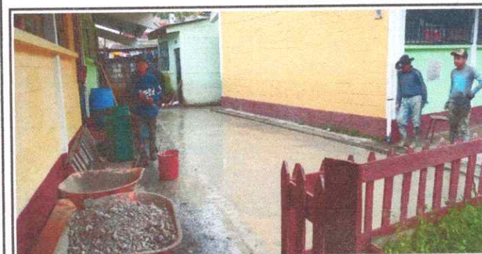
Foto 5: Reparación piso patio
