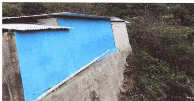
Foto 7: Finalización del mejoramiento de muro por humedad (repello y cernido).
