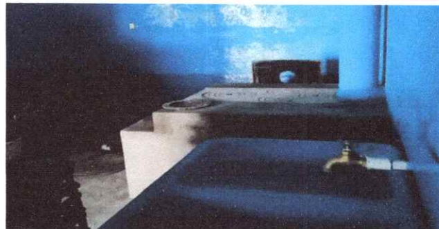
Foto 8: Finalización del trabajo de estufa artesanal y mesa de concreto.
