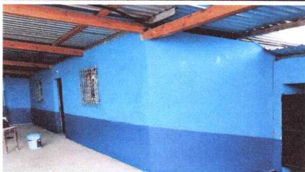
Foto 9: Finalización de repello y cernido en paredes de la cocina.
