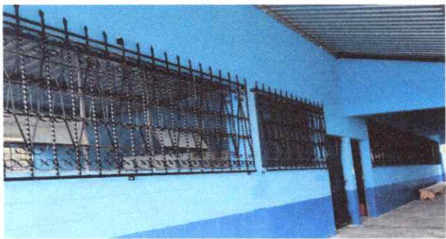
Foto 3: Finalización del trabajo de Sustitución de balcones en la parte frontal.
