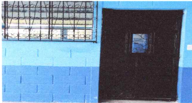
Foto 1: Finalización de la sustitución de puerta de metal en aula.
