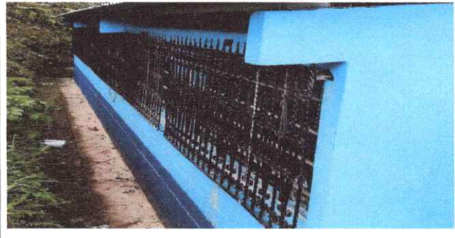
Foto 4: Finalización del trabajo de Sustitución de balcones de metal de la parte posterior de las aulas.
