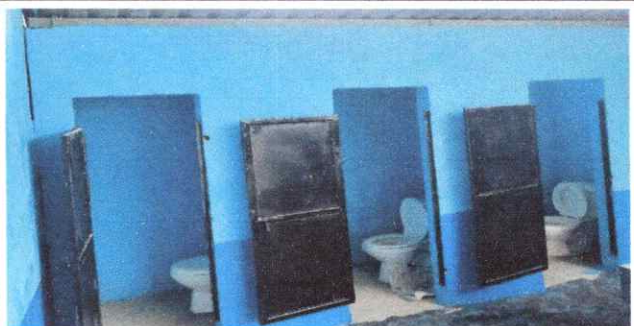
Foto 6: Finalización de la Sustitución de la tasa de inodoro.
