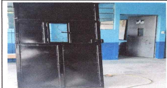
Foto1: Sustrucción de puerta de metal de un aula.
