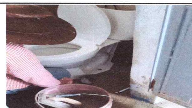
Foto 6: Sustrucción de las tasas de inodoro.
