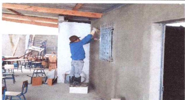
Foto 9: Mejoramiento de repello y cernido en paredes de cocina.
