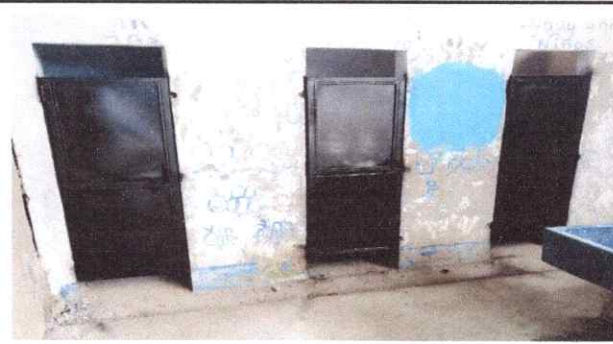
Foto 2: Sustrucción de puertas de metal en servicios sanitarios.
