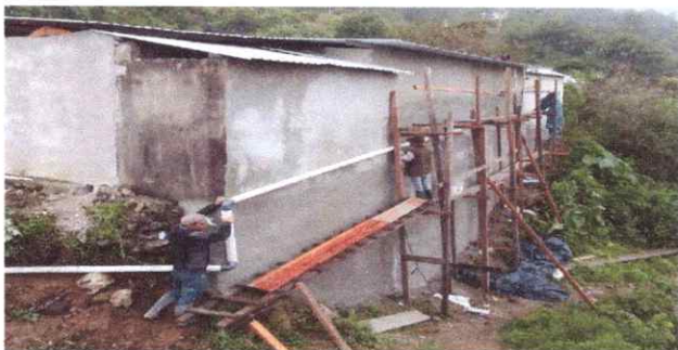
Foto 7: Mejoramiento de muro por humedad (repello y cernido)
