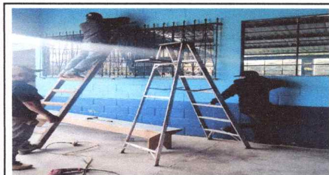
Foto 3: Sustrucción de balcones de metal en la parte frontal.
