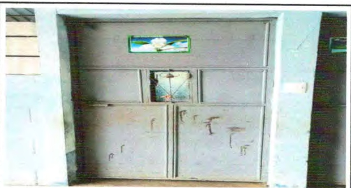
Foto 4: Puerta oxidada en malas condiciones de una de las aulas, es necesario reemplazarla,
