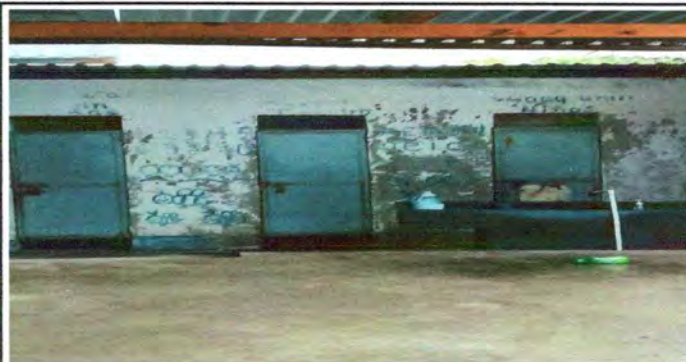
Foto 10: Puertas oxidadas en malas condiciones de los baños en pésimo estado, es necesario cambiarlos.
