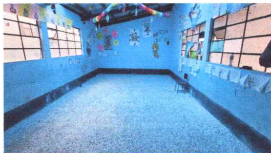
Foto 2: Piso de granito en aula 2 módulo 2
