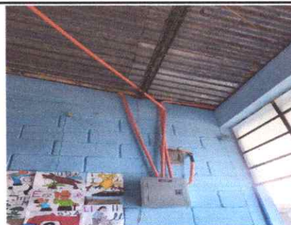
Foto 6: Instalación de tablero para flipones. Módulo 1
