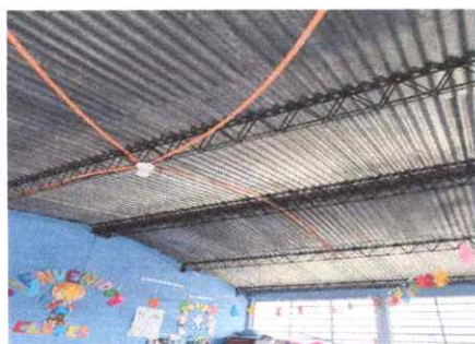
Foto 5: Cambio del sistema eléctrico en aula 4 módulo 1
