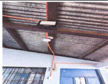
Foto 4: Cambio de filipon e instalación eléctrica en corredor del módulo 2.
