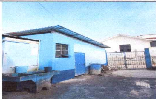
Foto1: Ventana instalada y pared mejorada en aula 1 del módulo 4.
