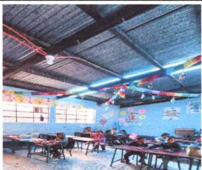
Foto 3: Instalación eléctrica y reparación de techo. Aula 3 módulo 2.
