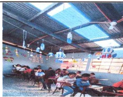
Foto 6: Reparación de techo en aulas del módulo 2.
