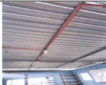
Foto 2: Cambio completo de techo con soporte de metal e instalación eléctrica.
