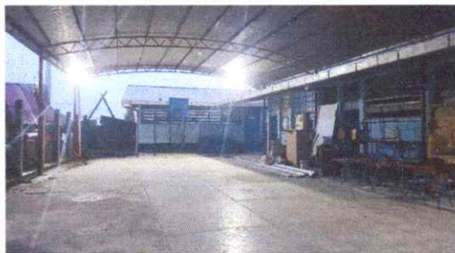
Foto 5: Iluminación cancha deportiva. (lado oeste)
