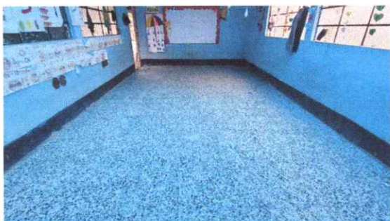
Foto 3: Piso de granito en aula 3 módulo 2
