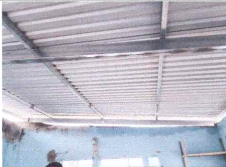
Foto1: Instalación de la estructura de Metal
