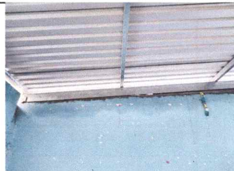
Foto 4: Cambio completo del techo de lámina
