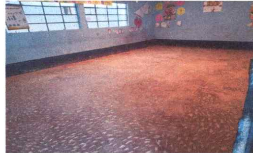
Foto 2: Remoción de torta de cemento en aula 2
