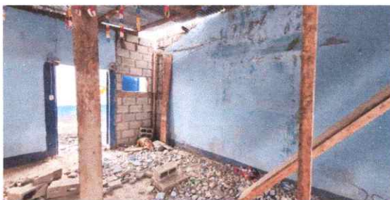
Foto 5: Reconstrucción de pared para instalación de ventana.
