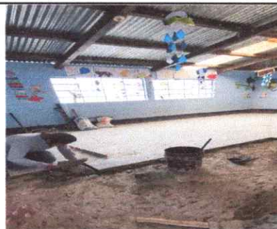
Foto 2: Instalación de granito en aula No. 1 módulo 2
