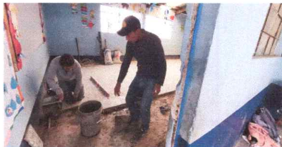
Foto 6: Instalación de piso de granito. Aula 3. Módulo 1
