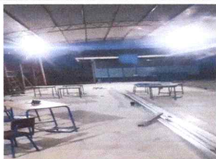
Foto 5: Mejora en las instalaciones eléctricas del patio (cancha deportiva).
