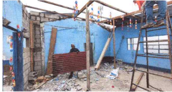
Foto 2: Retiro de techo de lamina.
