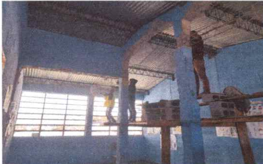
Foto 3: Cambio del soporte de metal
