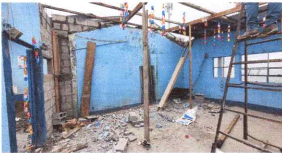
Foto 3: Retiro de soporte de madera.
