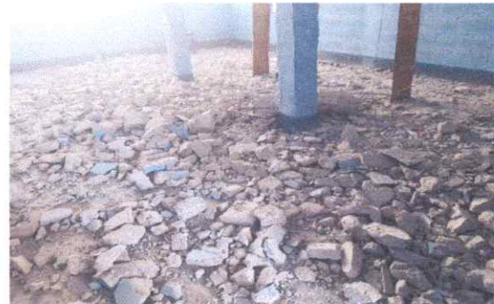
Foto 4: Eliminación de columnas intermedias.
