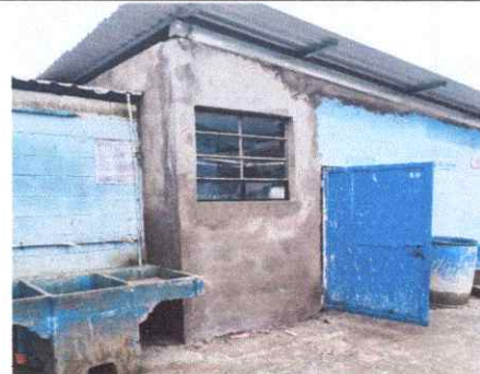
Foto 2: Cambio de Ventana
