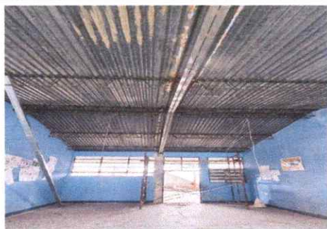
Foto 3: Cambio de instalación eléctrica.
