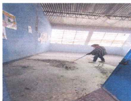
Foto 4: Remoción de tortas de cemento aula 3 del módulo 1
