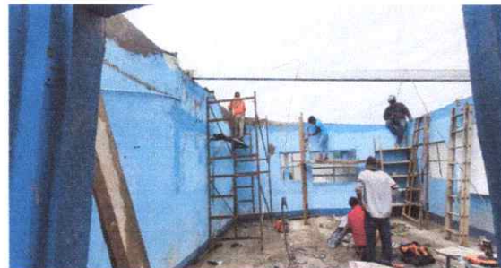
Foto 4: Instalación de soporte de metal.
