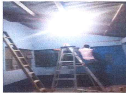
Foto 6: Cambio del cableado eléctrico en corredores.
