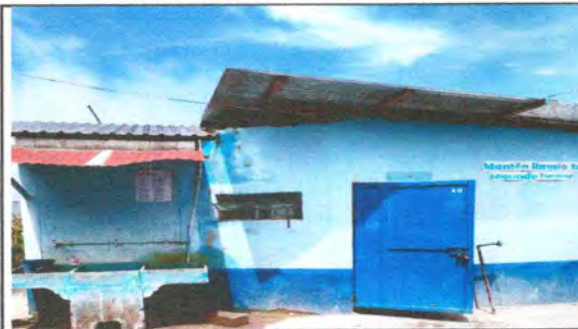
Foto 3: SUSTITUCIÓN DE VENTANA
