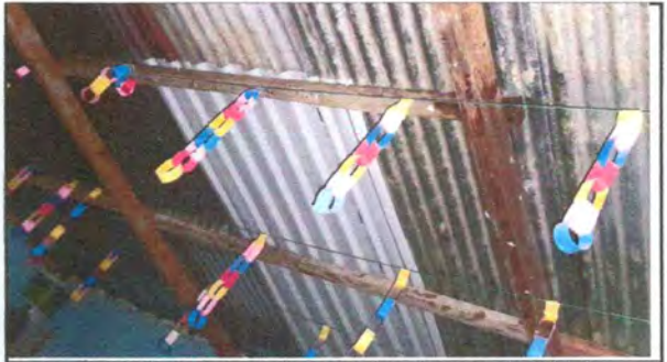
Foto 4: SUSTITUCIÓN DE ESTRUCTURA MADERA POR METAL
