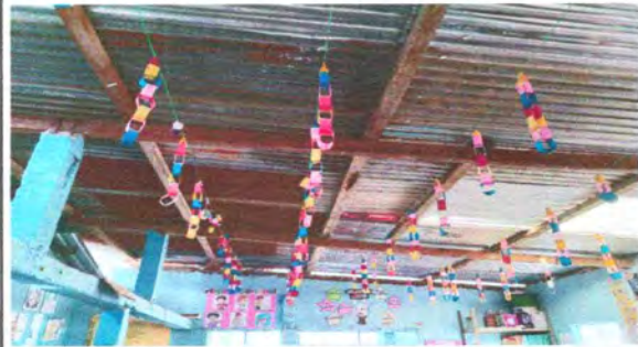
Foto1: CAMBIO DE CUBIERTA DE LAMINA
