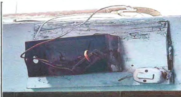
Foto 11: FLIPONES DETERIORADOS
