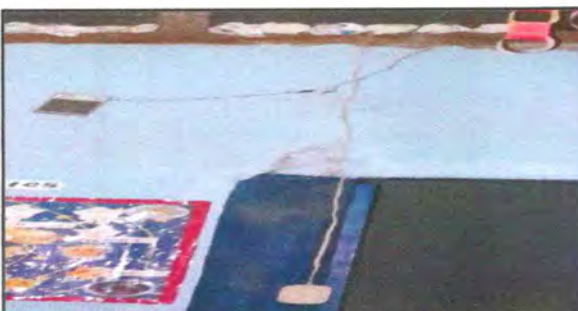
Foto 5: REPARACIÓN DE SISTEMA ELECTRICO
