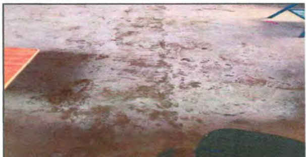
Foto 6: REPARACIÓN DE PISO DE TORTA DE CONCRETO
