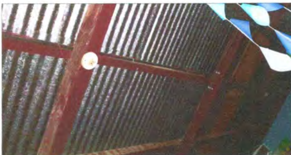
Foto 11: REPARACIÓN DE SISTEMA ELECTRICO
