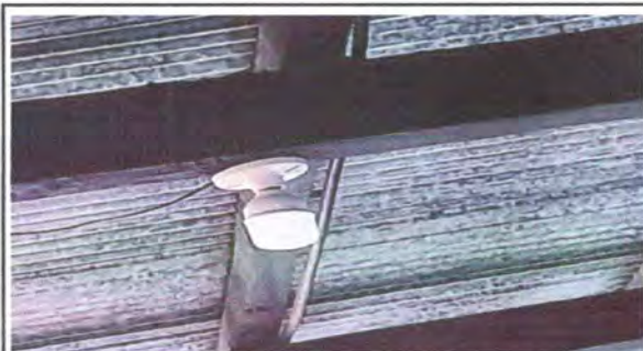
Foto 15: FOCOS DE ENTECHADO CON ACCESORIOS Y CONEXIONES INADECUADOS
