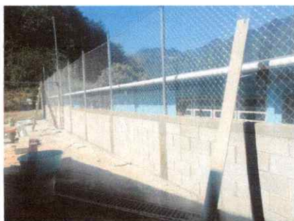
Foto 5: Sustitución de muro perimetral
