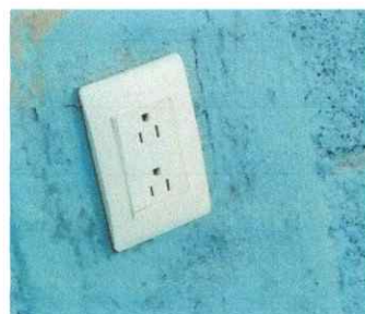
Foto 4: Sustitución de tomacorrientes
