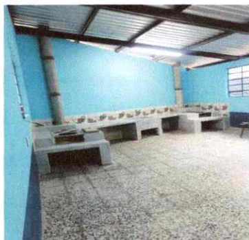
Foto1: Sustitución de estufa rural
