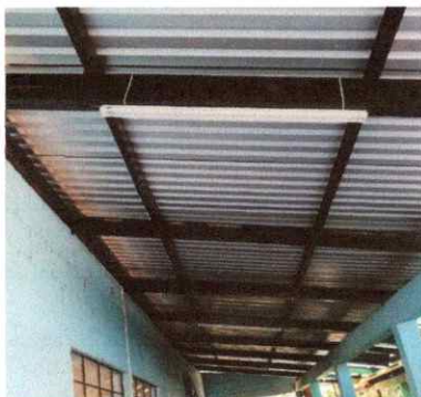
Foto 3: Sustitución de lamparas tipo LED
