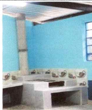
Foto 2: Instalación de azulejo en estufa rural
