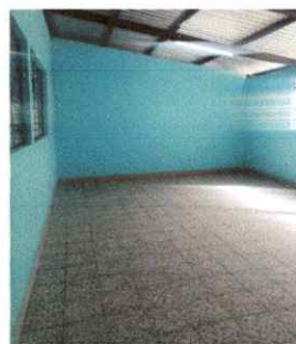
Foto 6: Reparación de piso de concreto en aula por granito
