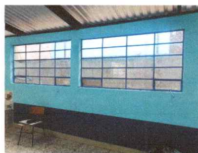
Foto 10: Mantenimiento a estructura de metal de ventana
