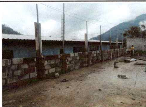
Foto 5: Mejoramiento de muro perimetral
