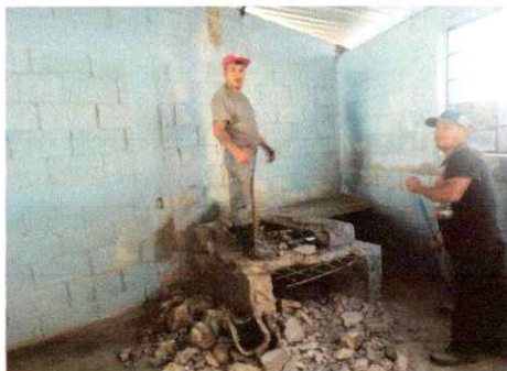
Foto1: Sustitución de estufa rural
