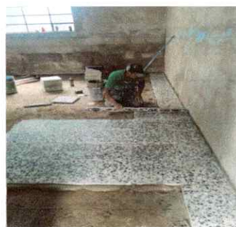
Foto 6: Reparación de piso de concreto en aula por granito
