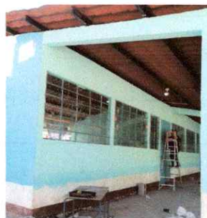
Foto 8: Pintura en interiores y exteriores de aula
