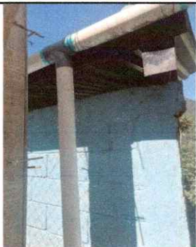
Foto 7: Reparación de bajada de agua pluvial con tubo pvc 3 Pulg.
