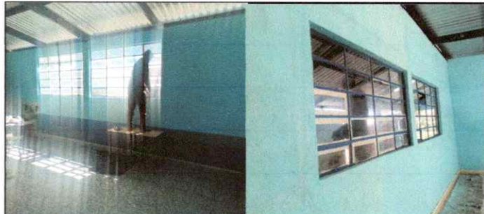
Foto 10: Mantenimiento a estructura de metal de ventana
