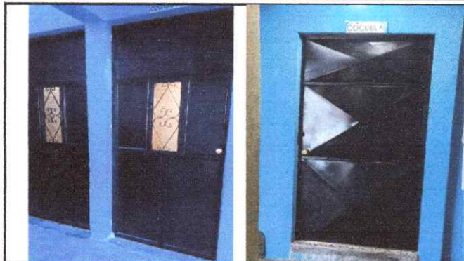
Foto 1: Puertas de aulas, cocina y dirección reparadas y terminadas
