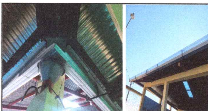
Foto 5: Canales y bajadas de agua instaladas y sustituidas
