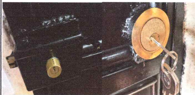
Foto 2: Chapas de puertas de aulas, cocina y dirección sustituidas
