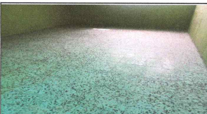
Foto 4: A la vista se observa la sustitución de piso de granito terminada
