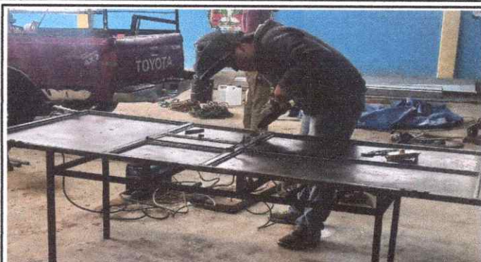
Foto 2: Sustitución de chapas de puertas en proceso.
