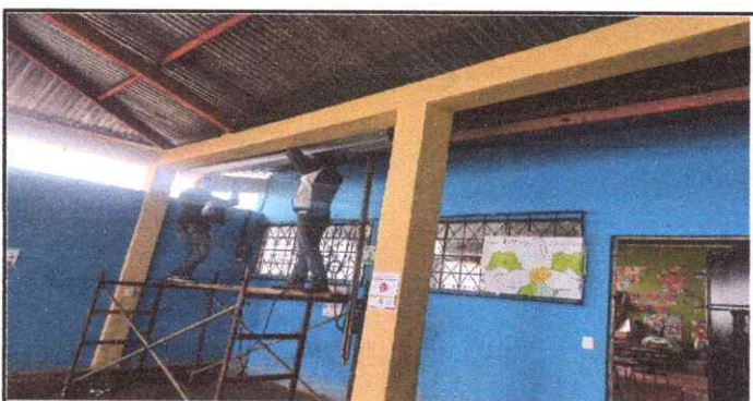
Foto 5: Canales y bajadas en proceso de sustitución
