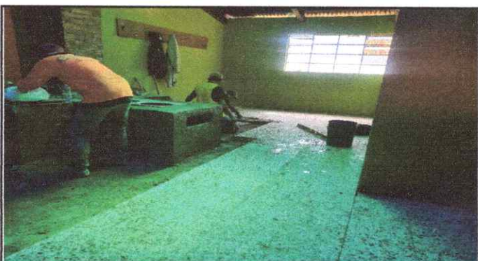
Foto 4: La cocina esta tomando forma por la sustitución de piso de granito
