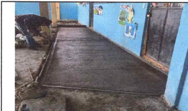
Foto 3: Se observa la reparación del piso de torta de cemento
