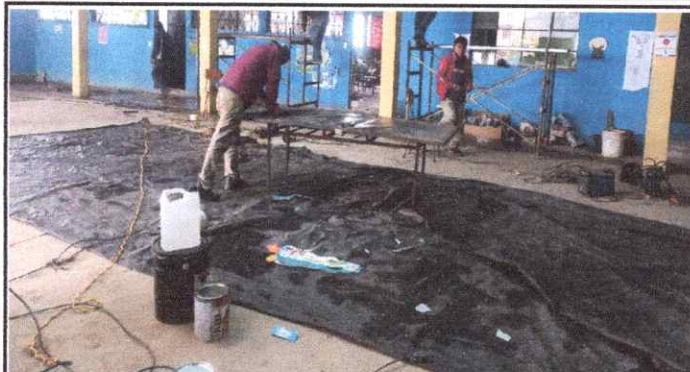
Foto1: Lijado, cepillado, sujección y aplicado de pintura a cada una de las puertas de las aulas, cocina y dirección.
