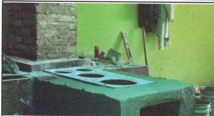
Foto 7: Plancha de metal de cocina en proceso de sustitución
