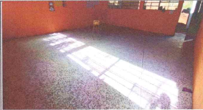
Foto1: Piso de granito colocado
