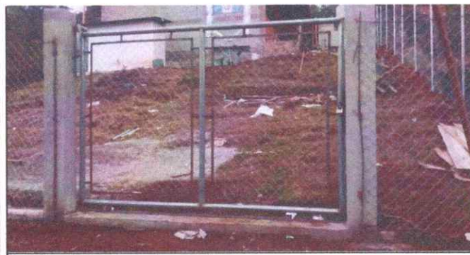
Foto 11: Porton deslizable instalado
