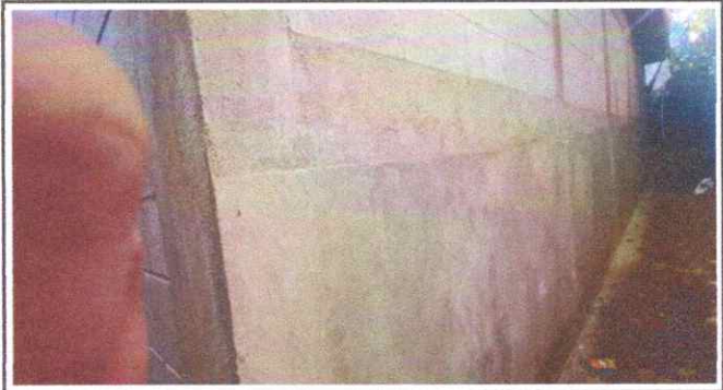
Foto 2: Repello de paredes externas completadas
