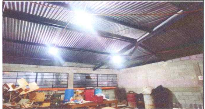
Foto 14: Plafoneras y focos nuevos con cableado eléctrico garantizado para su función
