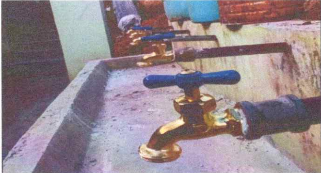
Foto 4: Nuevas llaves de chorro instaladas
