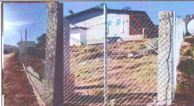
Foto 7: Cerco perimetral mejorado con postes de concreto y material galvanizado
