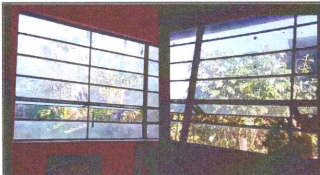
Foto 10: Reposición de todos los vidrios quebrados en las ventanas de todo el plantel educativo
