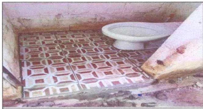
Foto 12: inodoros y ceramias en proceso de remodelación
