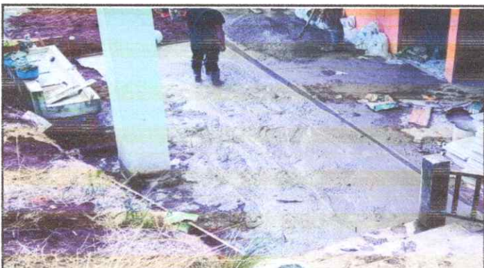
Foto 3: Colocación de la nueva plancha de concreto para el patio
