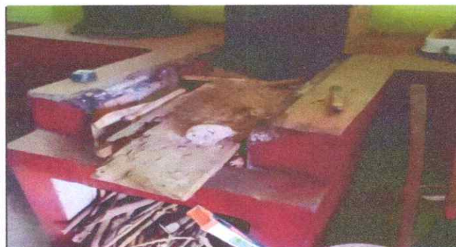
Foto 9: Preparación de las bases para la instalación de la plancha nueva de tres hornillas
