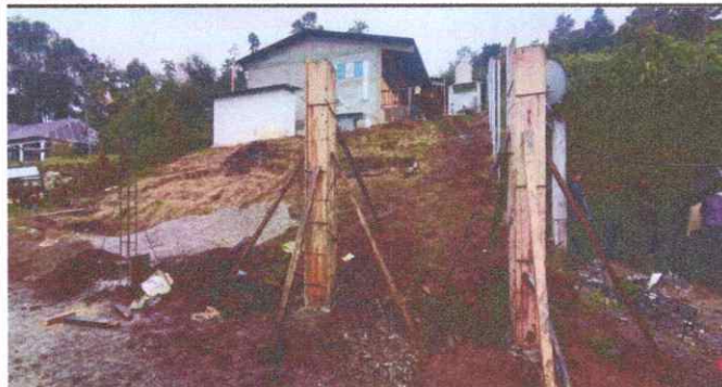
Foto 7: Colocación de postes de concreto y material inoxidable para el cerco perimetral
