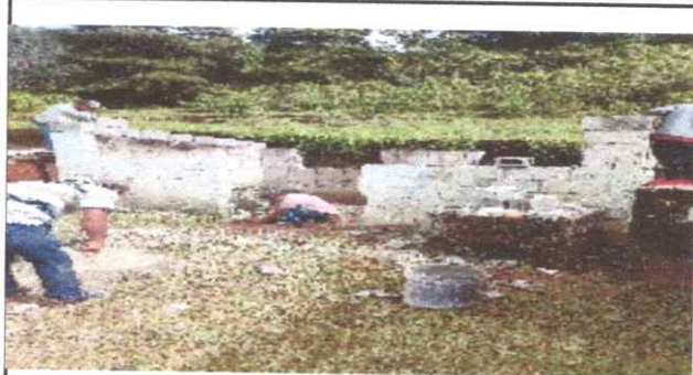
Foto 7: Techo de cocina y reparacion de cocina
