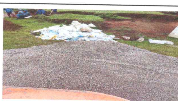
Foto 12: Arena que se utiliza para el cambio de piso
