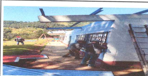
Foto 11: Techo de escuela que se estan cambiando
