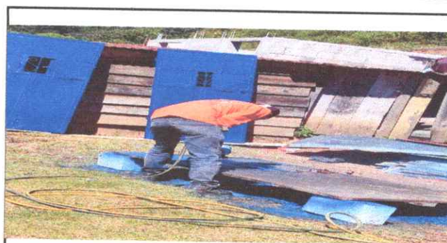
Foto 10: puertas que se estan pintando
