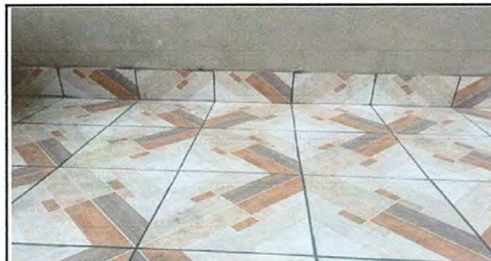
Foto 6: piso ceramico instalado
