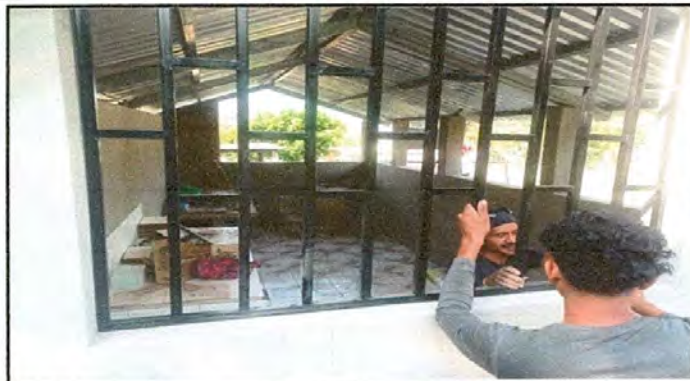
Foto 2: ventana balcon nueva instalada
