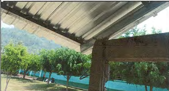
Foto1: estructura portante de metal para techo finalizado
