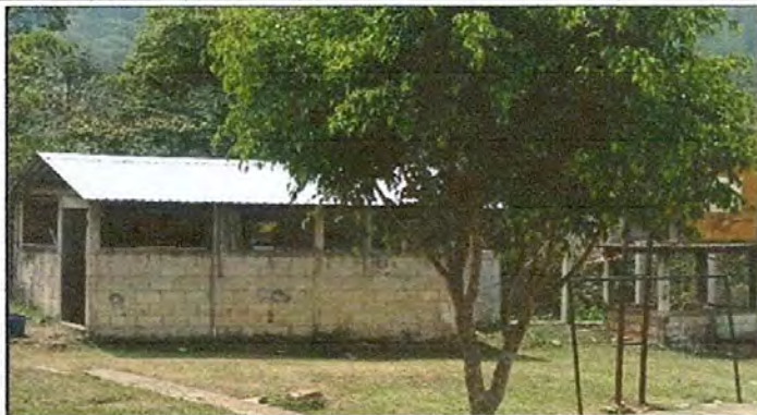
Foto 1: techo de lamina troquelada nueva instalada
