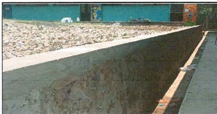
Foto 5: muro de contension finalizado
