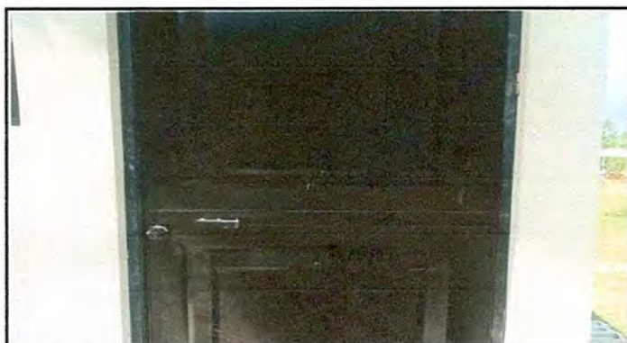
Foto 3: puerta de lamina galvanizada nueva instalada
