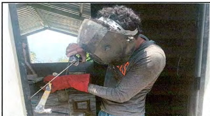
Foto 3: proceso de fijacion de marcos para puerta de lamina galvanizada con soldadura
