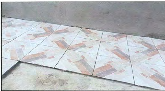
Foto 6: proceso de pegado de piso ceramico
