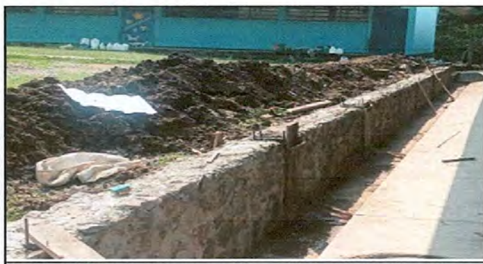
Foto 5: fundicion de columnas para reforzamiento del muro de contención
