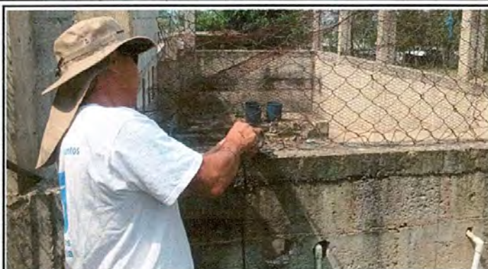
Foto 2: eliminacion de malla como estructura de ventana
