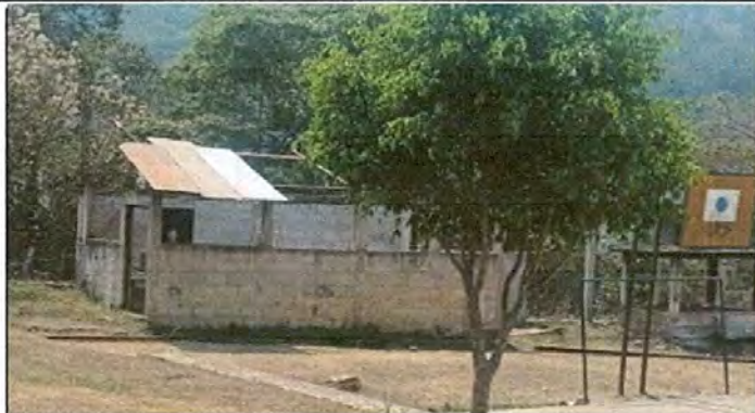
Foto 1: proceso de desmontaje de laminas en mal estado
