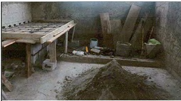
Foto 4: construccion de base de estufa rural
