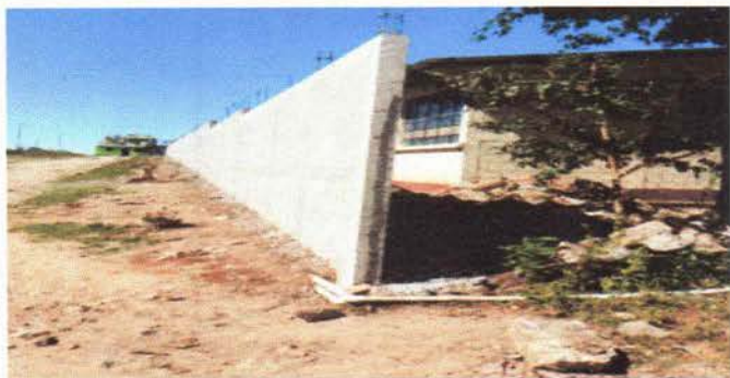
Foto1: Pared completada, parte exterior del lado izquierdo
