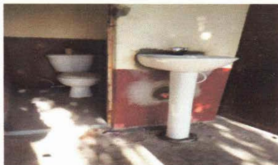
Foto 3: Tasa y lavamanos para vmujeres instalados
