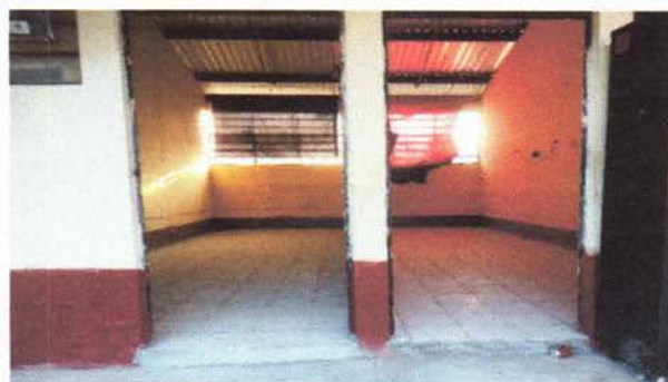
Foto 4: Piso de la sala docente en buenas condiciones
