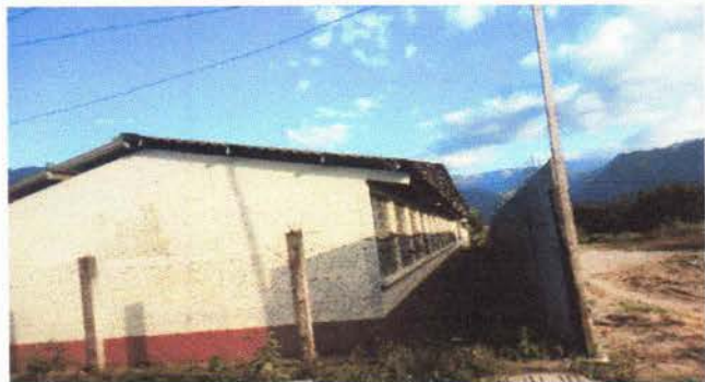
Foto 5: Muro de pared completado, parte externa lado derecho
