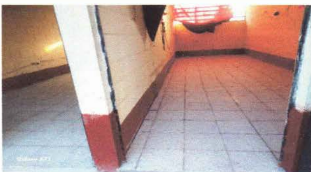
Foto 3: Instalación de piso de la dirección adecuadamente
