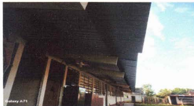
Foto 2. Techo de aulas finalizado satisfactoriamente, parte interna
