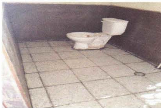
Foto 2: Piso de baños para mujeres instalado al cien porciento
