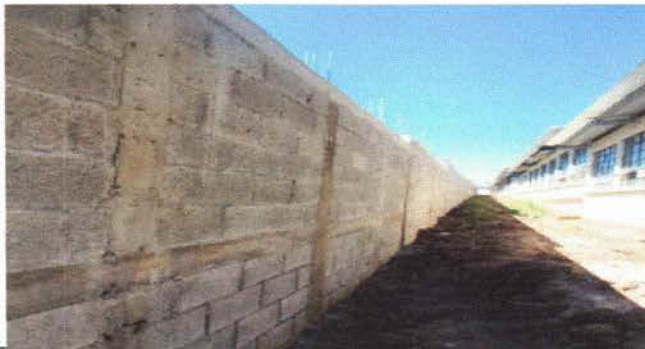
Foto 2: Muro completo observado en la parte interna del lado izquierdo
