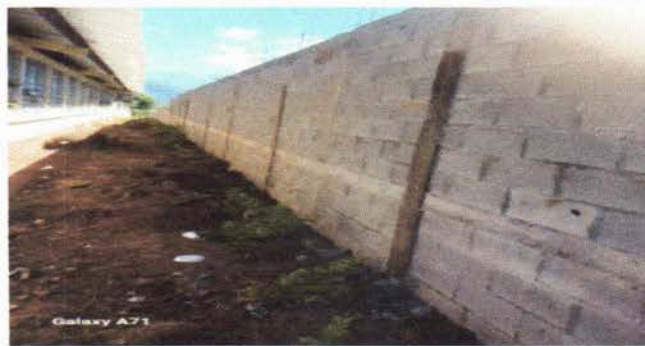
Foto 4: Muro de pared completado, parte derecha
