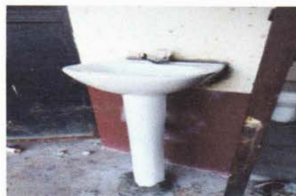
Foto 2: Lavamanos baño de hombres colocado
