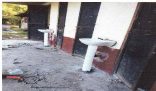
Foto 4: Lavamanos instalados para servicio para mujeres
