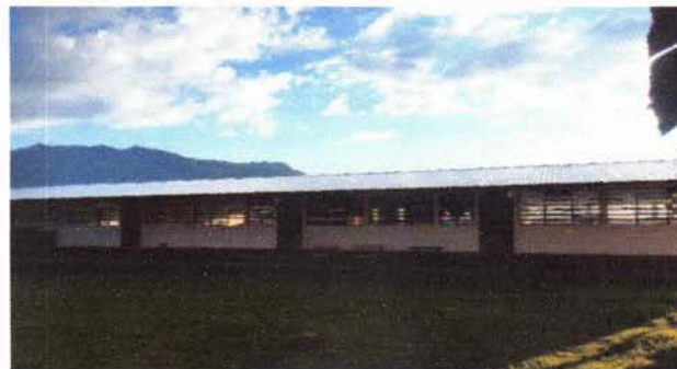
Foto 4. Techo finalizado de perfil derecho
