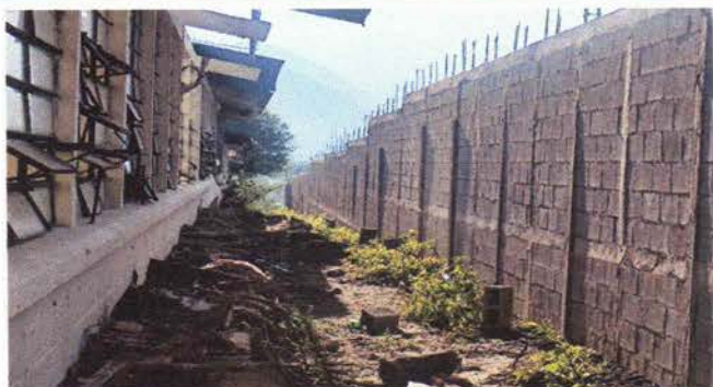
Foto 3: Muro perimetral completado visto del lado derecho parte interna
