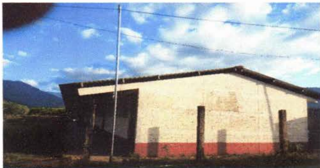
Foto1: Sustrucción de techo de aulas en su dos dimensiones
