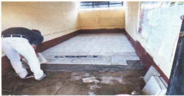
Foto 3: Colocación de piso en dirección
