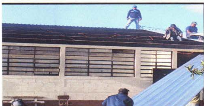
Foto 3. Avance en sustitución de techo
