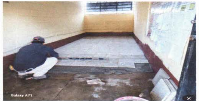
Foto 4: Colocación de piso en un sesenta por ciento en sala de docentes
