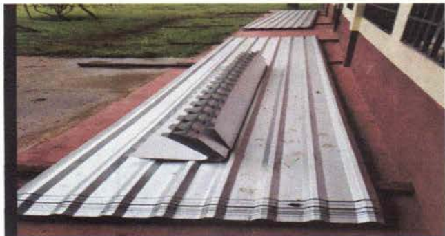
Foto1: Preparación de material para techo de aulas
