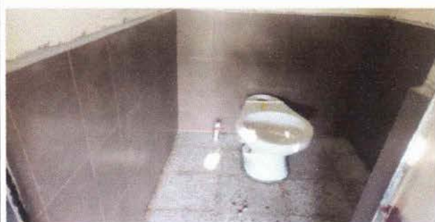
Foto 5: Colocación de tasas
