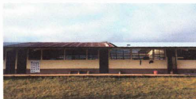
Foto 4. Colocación de techo en un sesenta por ciento
