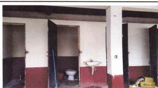
Foto 4: Colocación de azulejos y tasas
