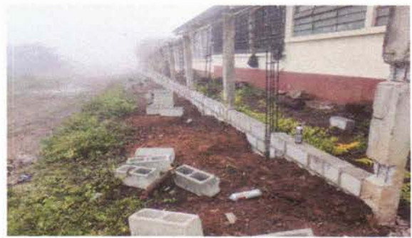
Foto 2: Colocación de block en el muro
