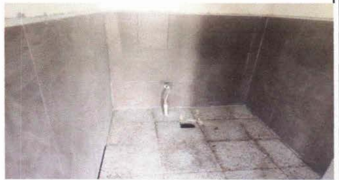
Foto 2: Colocación de piso en el baño
