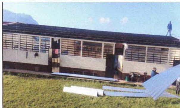
Foto 2: Inicio de la sustitución de techo de aulas
