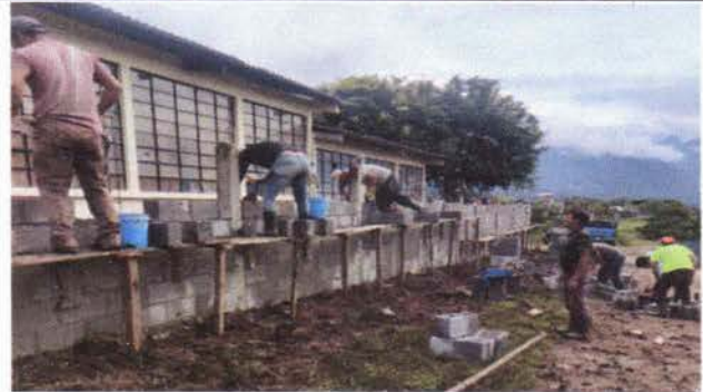
Foto 4: Avance de la pared del muro en un sesenta por ciento
