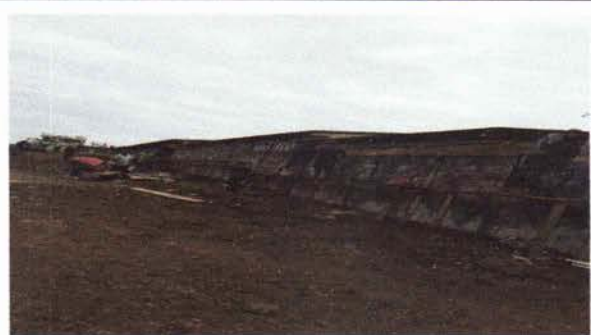
Foto 6. Avance de la pared del muro en un noventa por ciento
