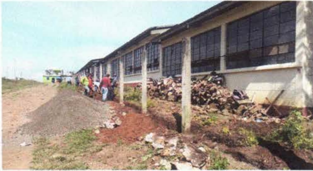
Foto1: Inicio del trabajo en muro, colocación de cemento
