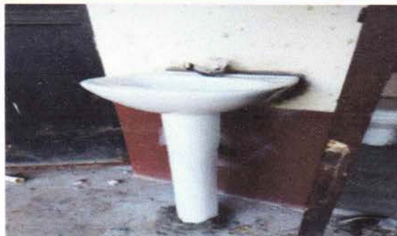
Foto 6: Colocación de lavamanos
