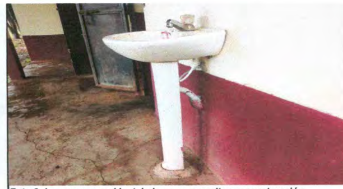
Foto 6: Lavamanos mal instalados que necesitan reconstrucción.
