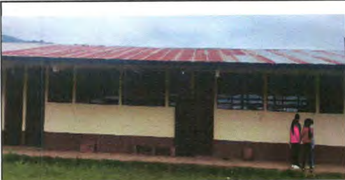
Foto1: Sustitución de techo de aulas
