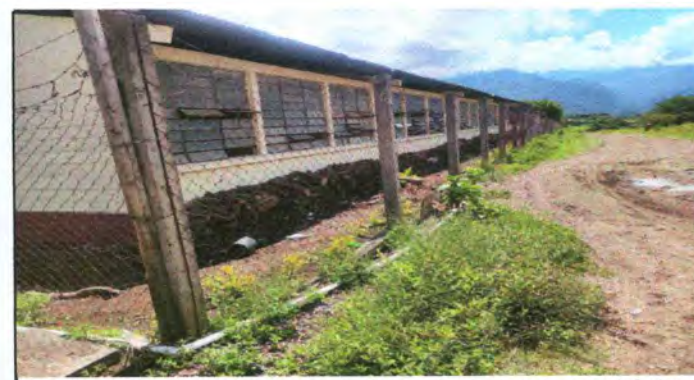
Foto 6: Circulación que necesita un refuerzo de block en la parte inferior.
