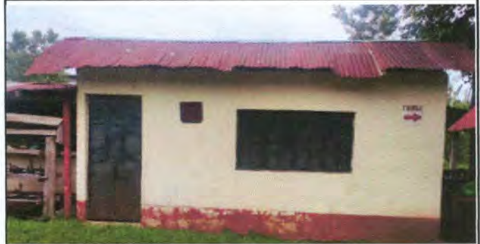
Foto 2:Sustitución techo de bodega
