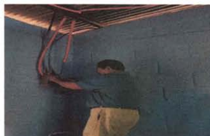
Foto 4: trabajando con la luz eléctrica
