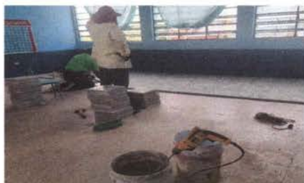
Foto 5: colocando piso de granito
