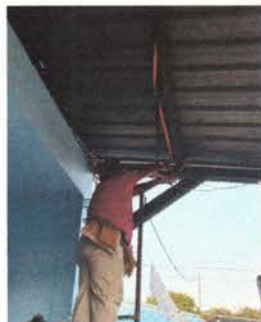
Foto 3: Trabajando para la reparación de la luz eléctrica
