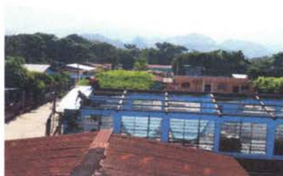
Foto 1: Cambiando el techo a las aulas
