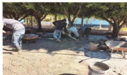
Foto 6: trabajando la torta de cemento
