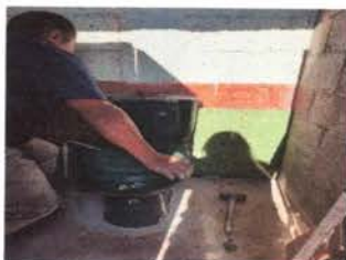
Foto1: Trabajando con la reparación de la taza
