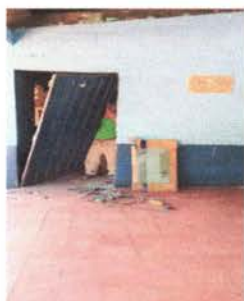
Foto 3: desmontando la puerta
