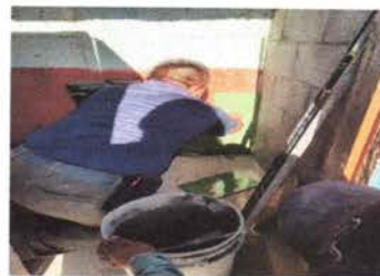
Foto 2: Colocando azulejo en el baño.
