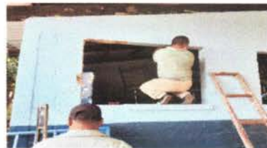
Foto 2: trabajando para la colocación de ventanas
