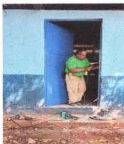
Foto1: colocando la segunda puerta
