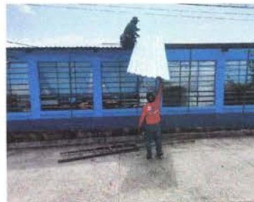
Foto 2: Entechando las aulas
