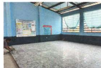
Foto 6: Colocando el piso de granito en una de las aulas
