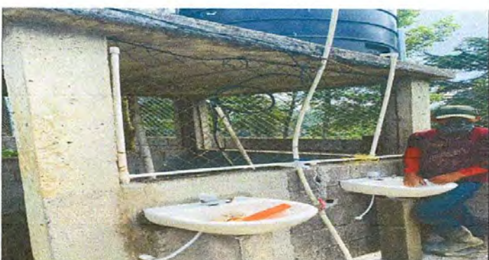
Foto 6: Sustitución de lavamanos
