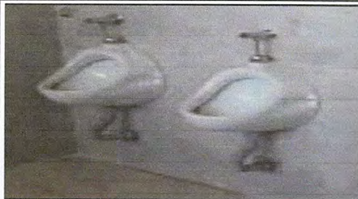
Foto 7: Sustitución de mingitorios
