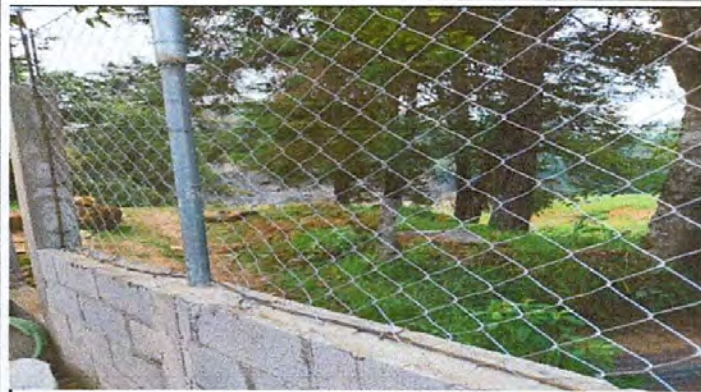
Foto1: Remozamiento de circulación del predio escolar
