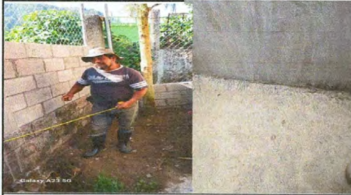
Foto7: Sustitución de mingitorio
