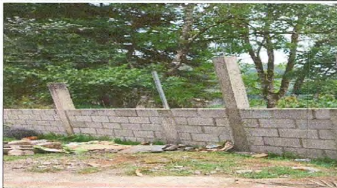
Foto 1: Remozamiento de circulación del predio escolar
