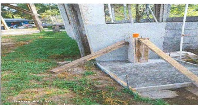
Foto 6: Sustitución de lavamanos
