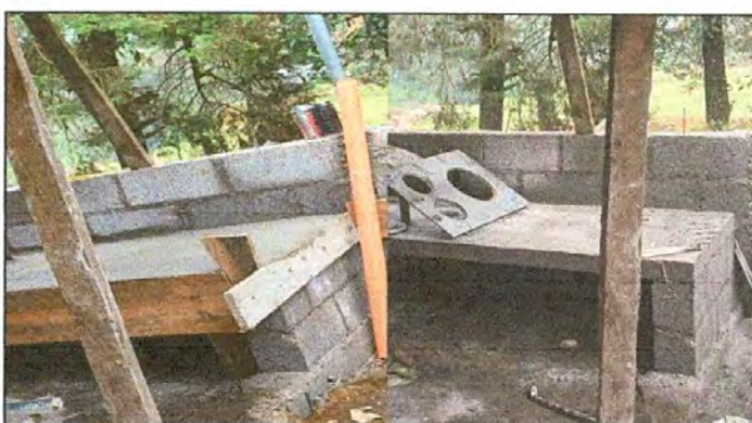
Foto 4: Sustitución y mejoramiento de plancha en mal estado
