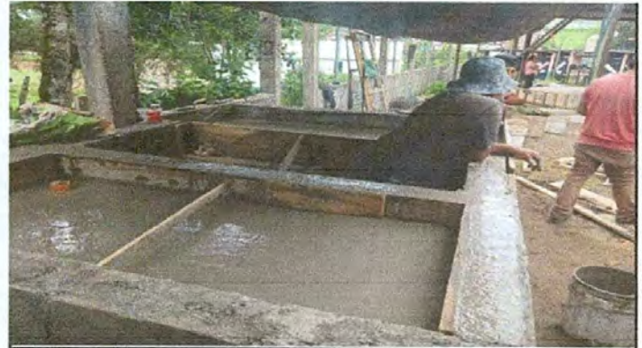
Foto 8: Sustitución de pila para cocina
