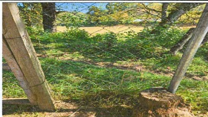
Foto 1: Remozamiento de circulación del predio escolar
