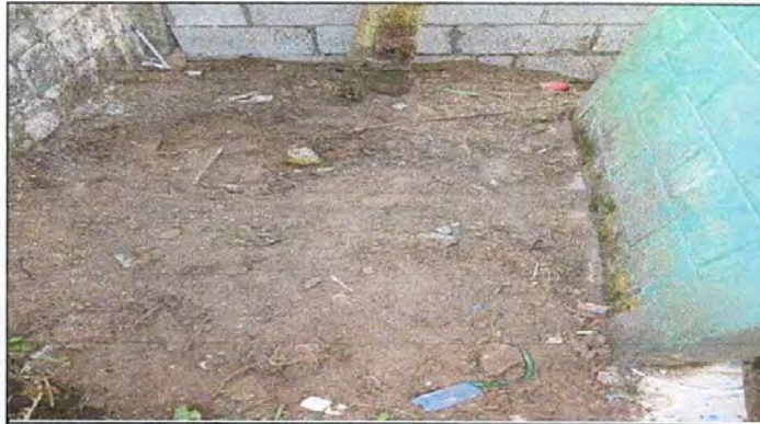
Foto 7: Sustitución de mingitorios
