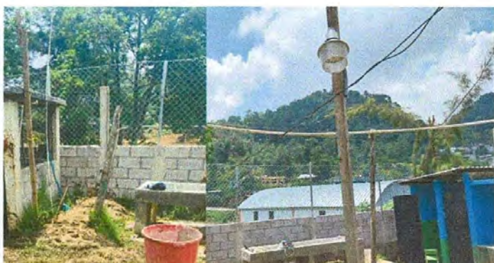
Foto 6: Sustitución de lavamanos
