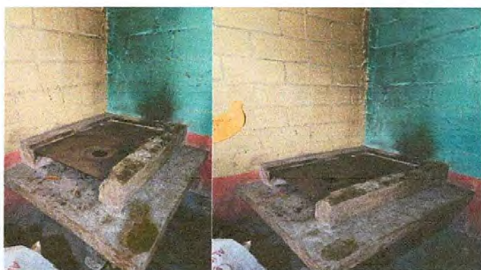
Foto 4: Sustitución y mejoramiento de planchas en mal estado
