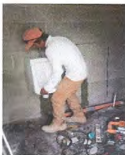
Foto 5: Instalación de migitorios.
