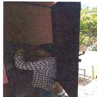
Foto 6: Instalación de puerta, en baños.
