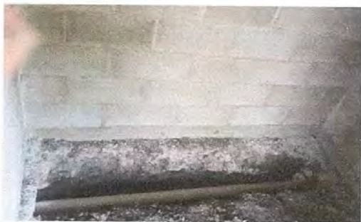
Foto 7: Instalación de tubería principal de aguas negras.
