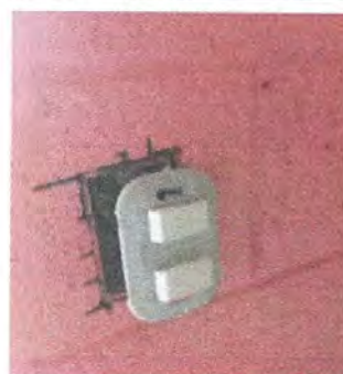
Foto 8: Trabajo de instalación eléctrica en baños.
