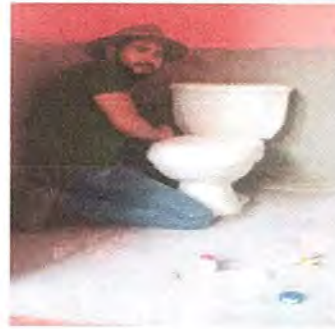
Foto 4: Instalación de inodoros.
