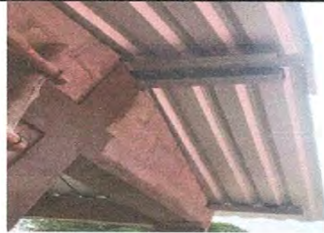
Foto 2: Instalación de lámina troquelada calibre 26 en baño.
