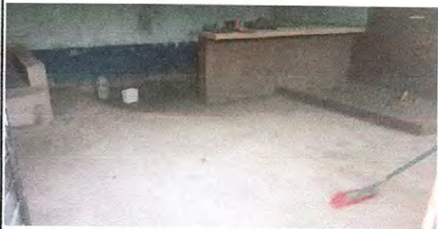
Foto 9: Instalación de contrapiso, previo a instalación de piso cerámico.
