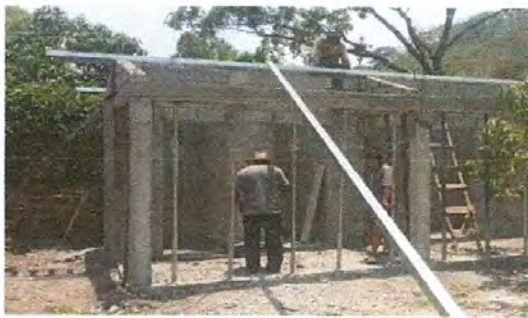
Foto 3: Instalación de estructura de soporte de metal, tubo galvanizado de 3x3 pulgadas
