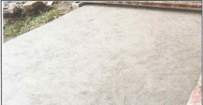
Foto 4: Reparación de piso de torta de concreto
