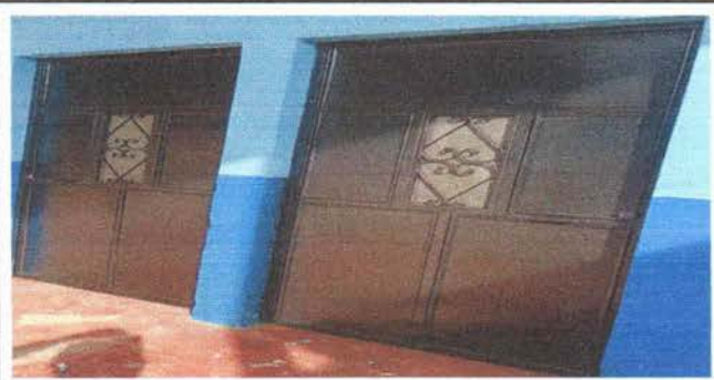
Foto 3: Mantenimiento a estructura lijado e aplicacón de pintura
