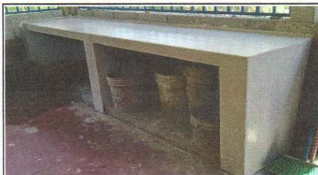
Foto 3: Mejoramiento de mesa de concreto
