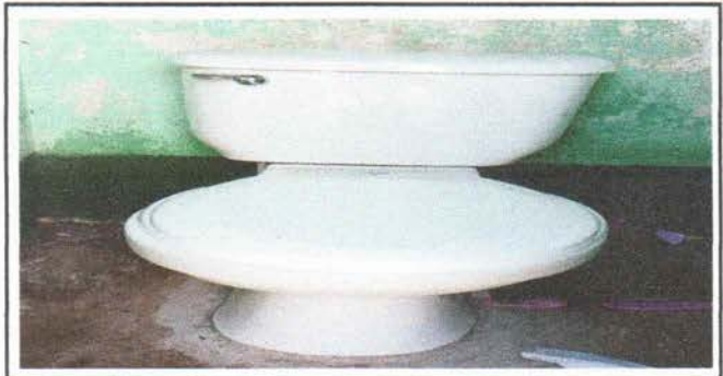
Foto 6: Sustrucción de inodoros
