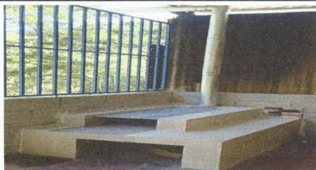
Foto1: Sustitución de estufa rural con base de plancha con zuleo
