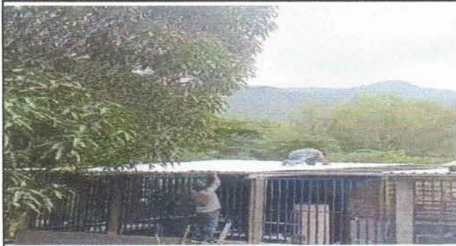
Foto 1: Sustrucción de laminas por lamina troquelada calibre 26 de 23 pies
