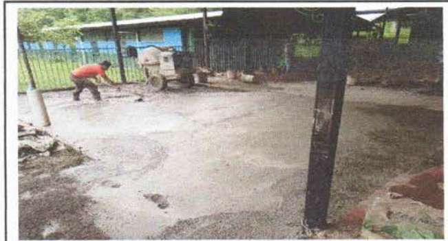
Foto 4: Reparación de piso de torta de concreto
