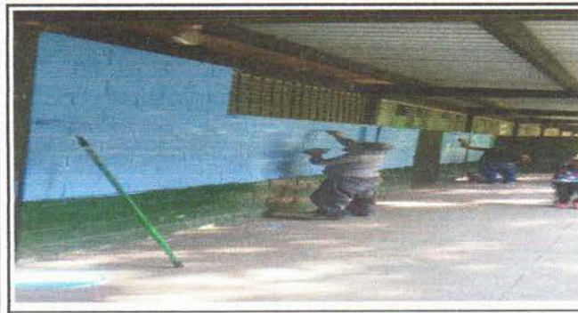
Foto 5: Pintura en muros exteriores e interiores
