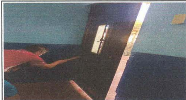
Foto 3: Mantenimiento a estructura lijado y aplicación de pintura
