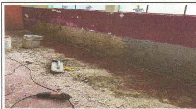
Foto 4: Reparacion de repello y cernido de pared
