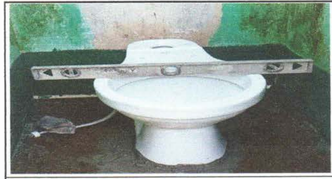
Foto 6: Sustrucción de inodoros
