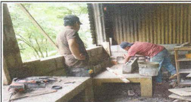
Foto1: Sustitución de estufa rural con base de plancha con zuleo
