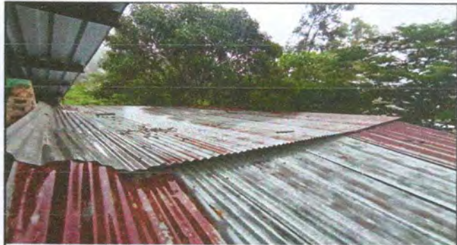
Foto 2: CUBIERTA DE LAMINA
