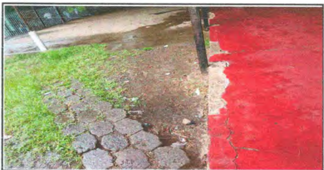
Foto 6: TORTA DE CEMENTO
