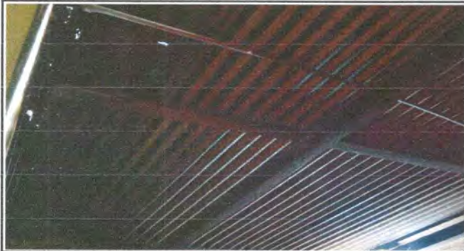
Foto1: CUBIERTA DE LAMINA
