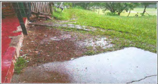
Foto 5: TORTA DE CEMENTO
