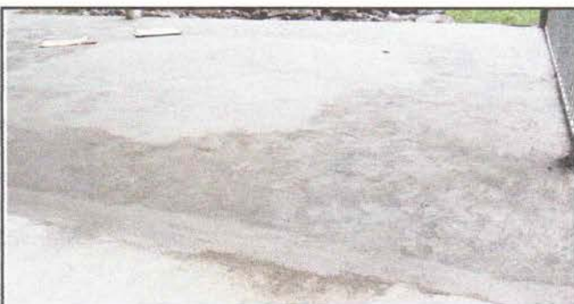
Foto 6: Sustitucion de piso de torta de concreto
