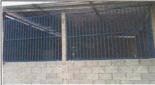
Foto1: Mejoramiento de baranda sobre muros de cocina
