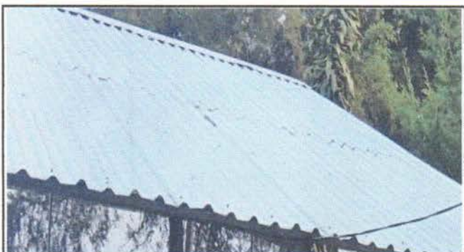
Foto 3: Sustitución de lámina por lamina aluzin calibre 26
