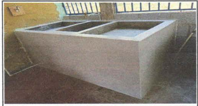
Foto 4: Mejoramiento de pila de concreto dentro de la cocina.
