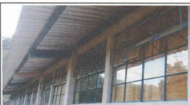
Foto 4: Sustitución de vidrios en ventanas de aulas
