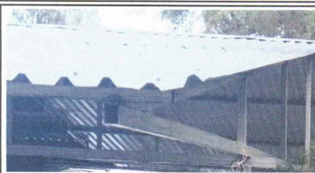
Foto 2: Sustitución de estructura de soporte de metal.
