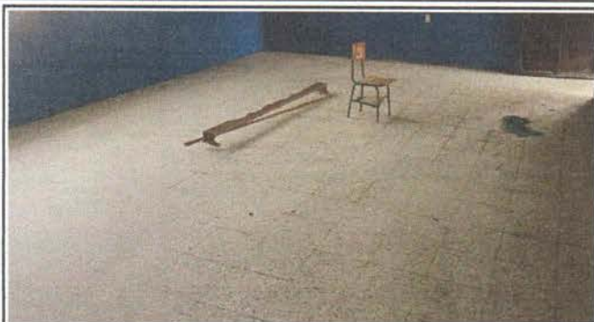
Foto1: Mejoramiento de piso de granito en el aula
