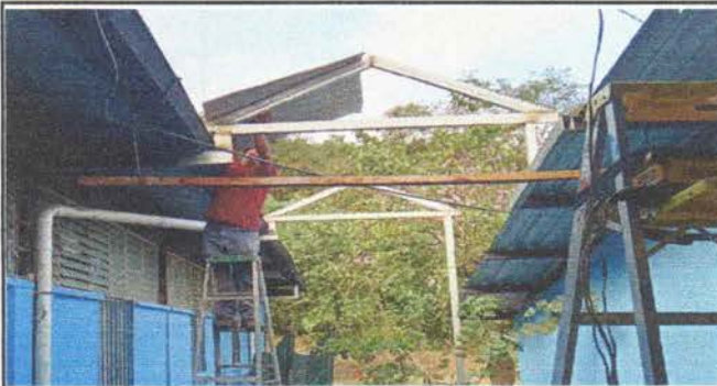
Foto 3: Sustitución de lámina por lamina aluzin calibre 26
