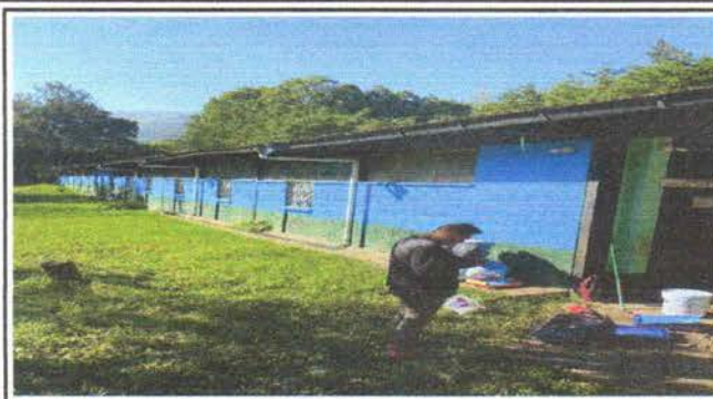
Foto 2: Pinturas en muros exteriores e interiores.
