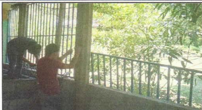
Foto 1: Mejoramiento de baranda sobre muros de cocina
