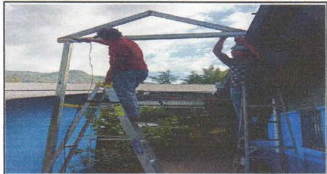
Foto 2: Sustitución de estructura de soporte de metal.
