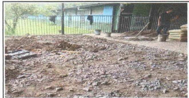
Foto 6: Sustitucion de piso de torta de concreto
