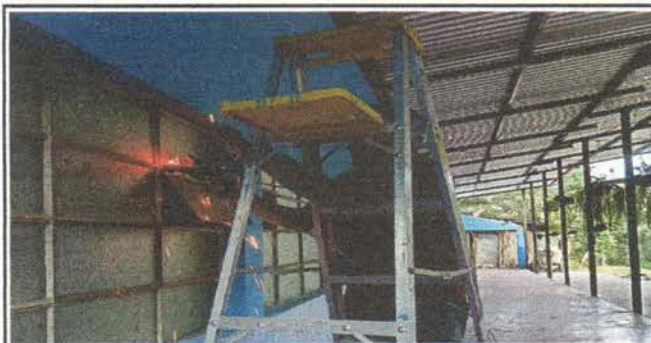
Foto 5: Mantenimientos de estructura de ventanas en aulas
