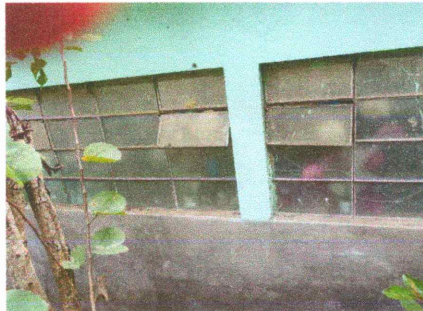
SUSTITUCIÓN DE VIDRIOS EN VENTANAS DE AULAS
