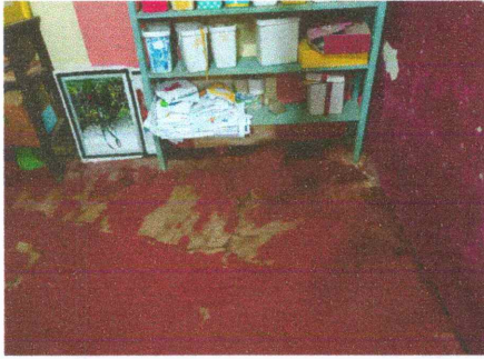
MEJORAMIENTO DE PISO DE GRANITO EN AULA
