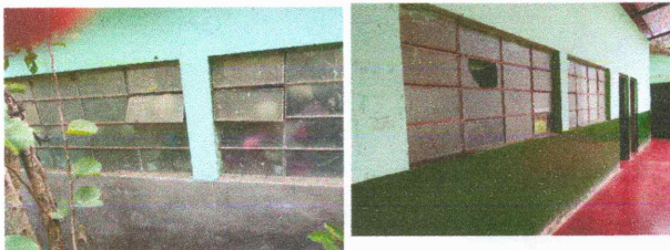
PINTURA EN MUROS EXTERIORES E INTERIORES
