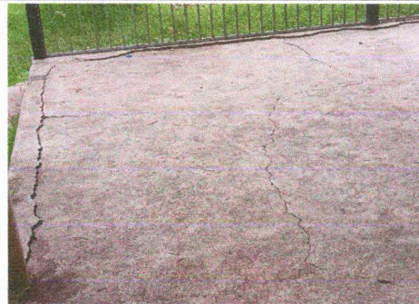
SUSTITUCIÓN DE PISO DE TORTA DE CONCRETO
