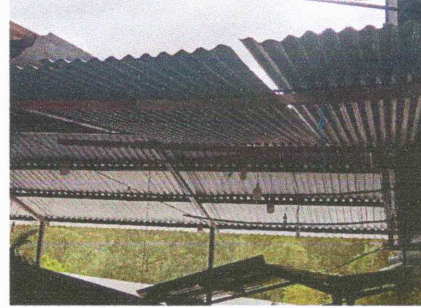
SUSTITUCIÓN DE ESTRUCTURA DE SOPORTE DE METAL
