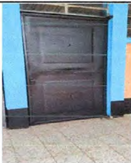
Foto 5: Sustitucion de puerta
