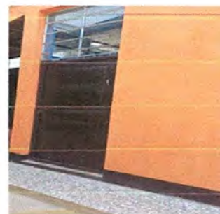
Foto 6: Sustitución de puerta
