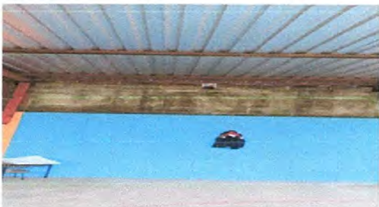
Foto 5: Sustitucion de laminas troqueladas aluzinc (cancha de basquetbol con saldo de economia)
