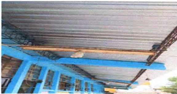
3. Sustitucion de laminas troqueladas aluzinc
