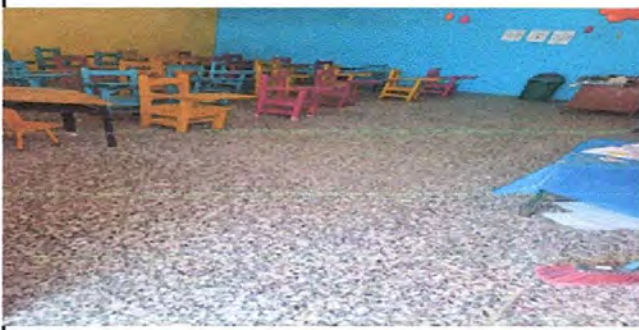
FOTO 1 sustitución de piso de granitp
