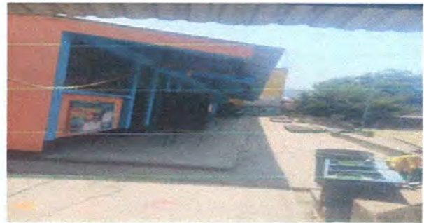
Foto 2: Sustitucion de laminas troqueladas aluzinc
