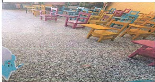
Foto 2: Sustitucion de piso de granito
