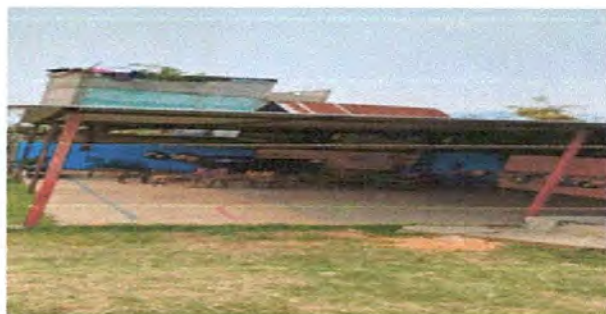
Foto 6: Sustitucion de lamina troquelada aluzinc( cancha de basquetbol con saldo de economia)
