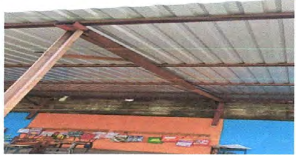
Foto 4: Sustitucion de laminas troqueladas aluzinc (cancha de basquet con saldo de economia)
