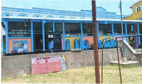
Foto1: Sustitucion de laminas troqueladas aluzinc
