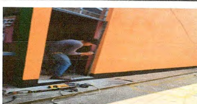
Foto 6: Sustitución de puertas.
