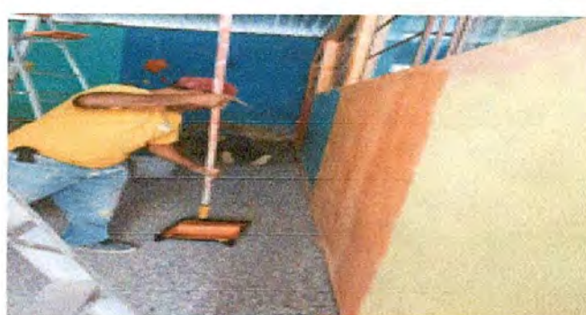
Foto 4: Pintado interior y exterior
