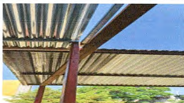
Foto 2: Sustitucion de laminas troqueladas aluzinc
