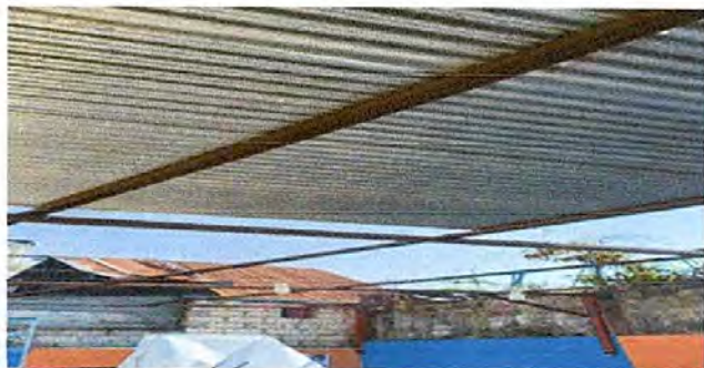
Foto1: Sustitucion de laminas troqueladas aluzinc
