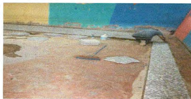
Foto 2: Sustitución de piso de granito
