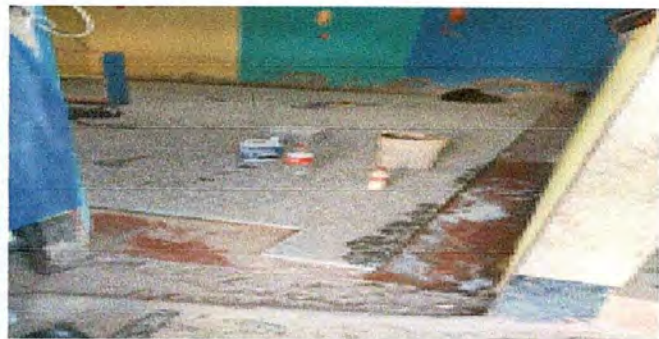
Foto 1: Sustitución de piso de granito
