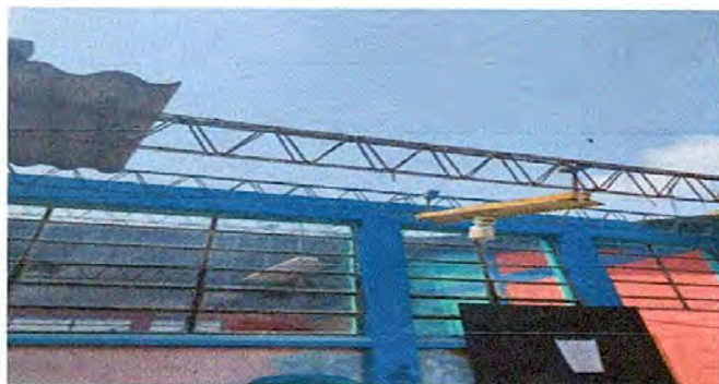
Foto1: Sustitucion de laminas troqueladas aluzinc
